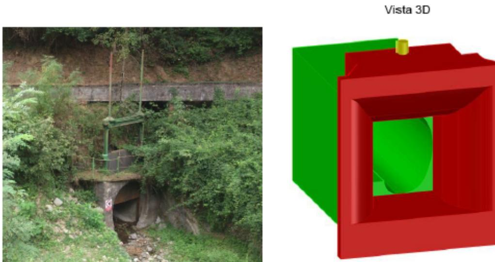
Figura 7.1: situazione esistente con paratoia e assonometria del nuovo manufatto di imbocco
