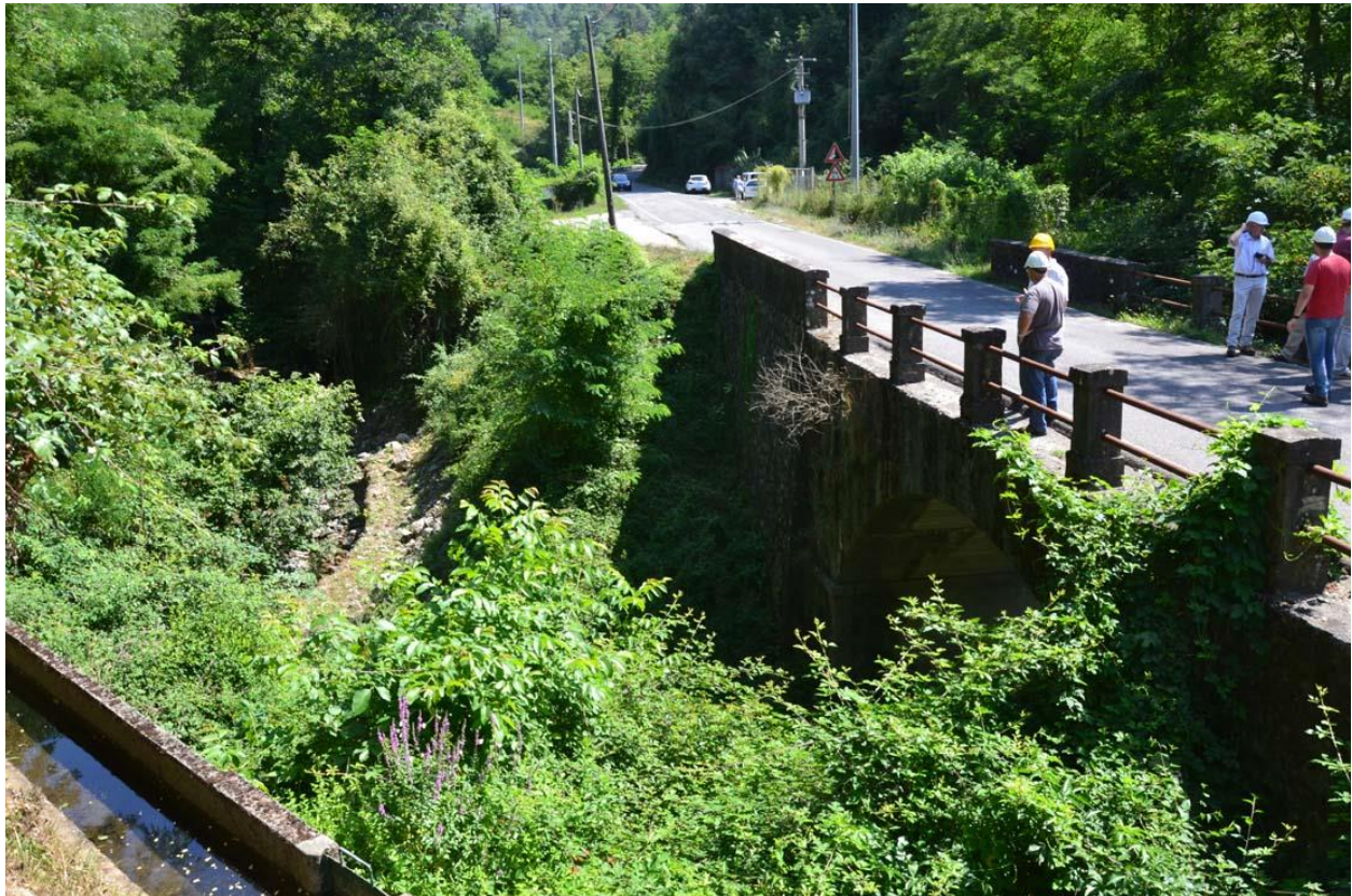
Figura 53 - Zona imbocco By-pass, sistemazione alveo: stato di fatto.
