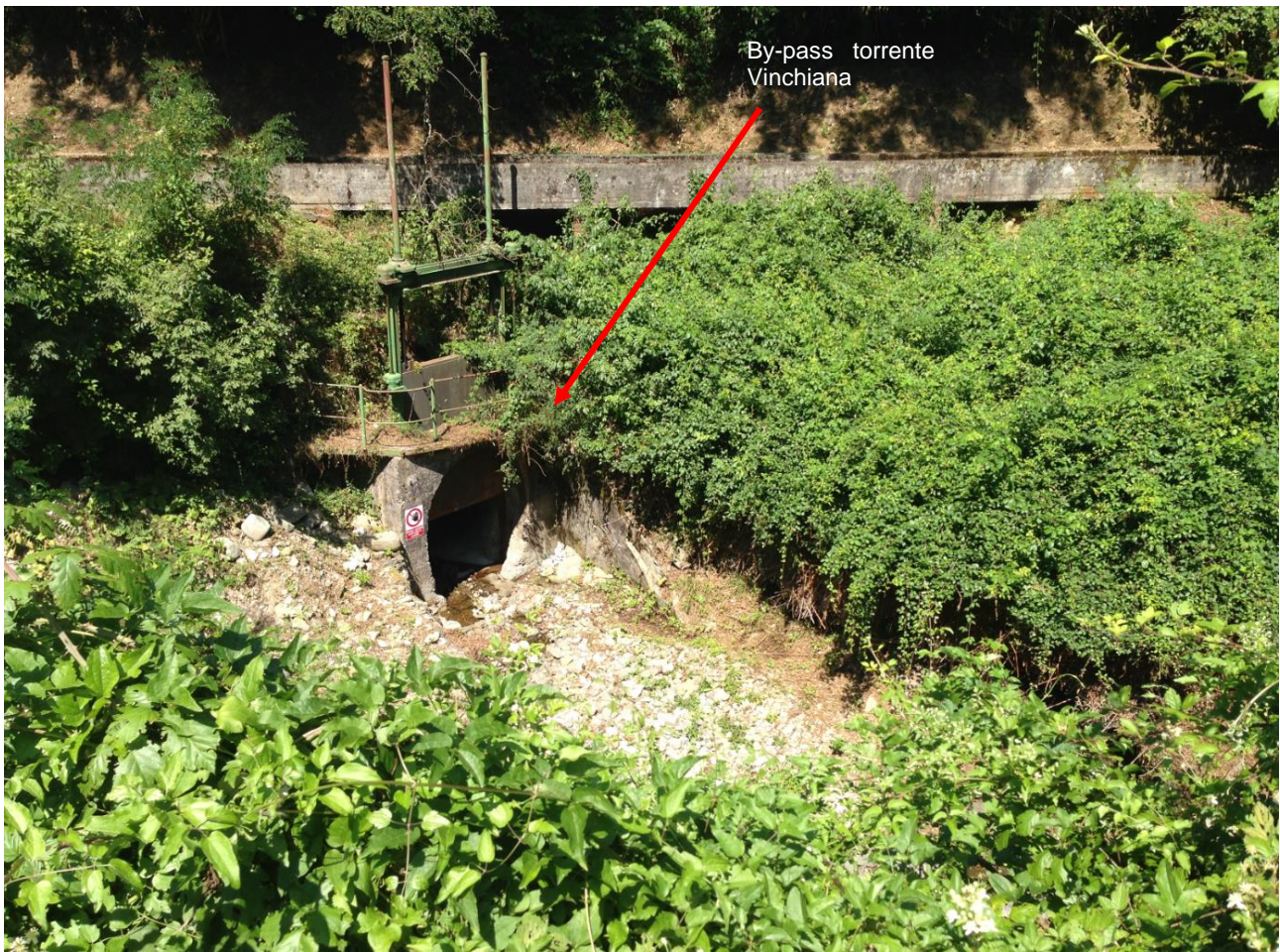
Foto 7 – Paratoia d'ingresso della galleria di By-pass sul torrente Vinchiana.
