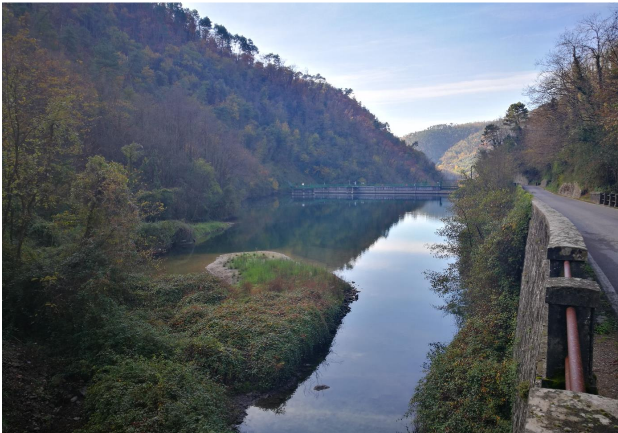
Foto 5 – Il bacino di accumulo e il corpo diga, vista da monte.
