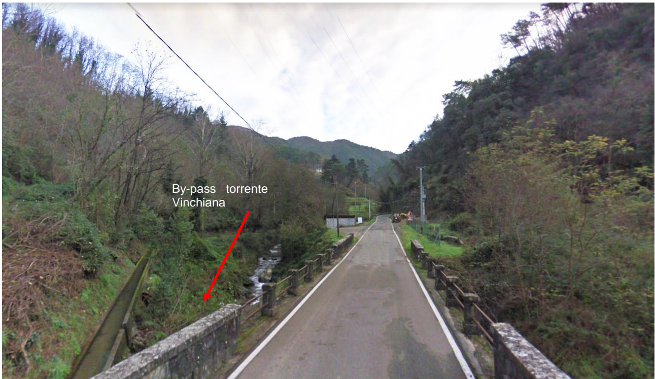
Foto 6 – Via Pieve dei Brancoli, tratto a monte del bacino in cui verranno realizzati i lavori sulla paratoia d'ingresso alla galleria di By-pass del torrente Vinchiana.
