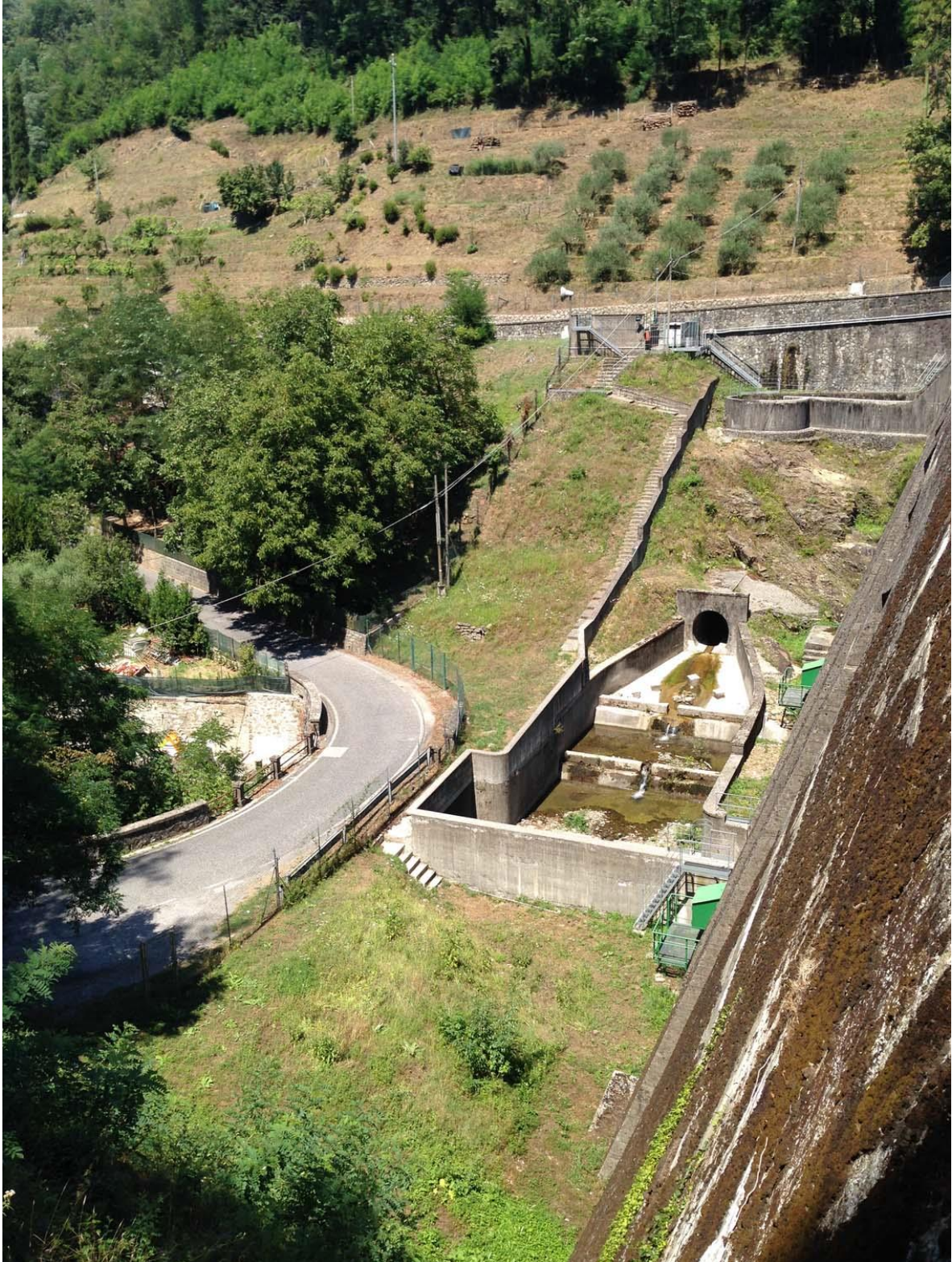
Figura 47 - Area a valle della diga: stato di fatto.
