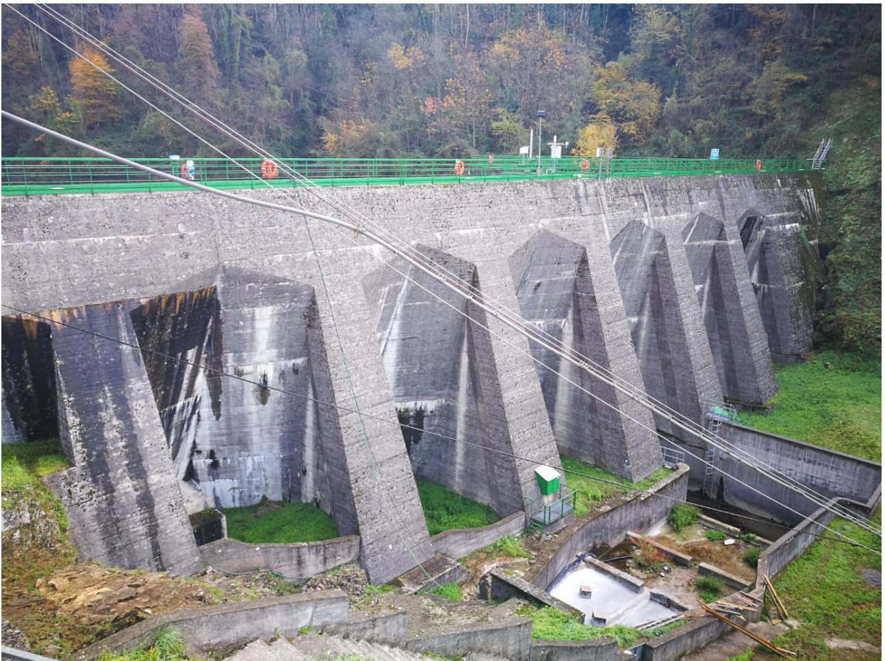
Foto 3 – Dettaglio del corpo diga visto da valle.
