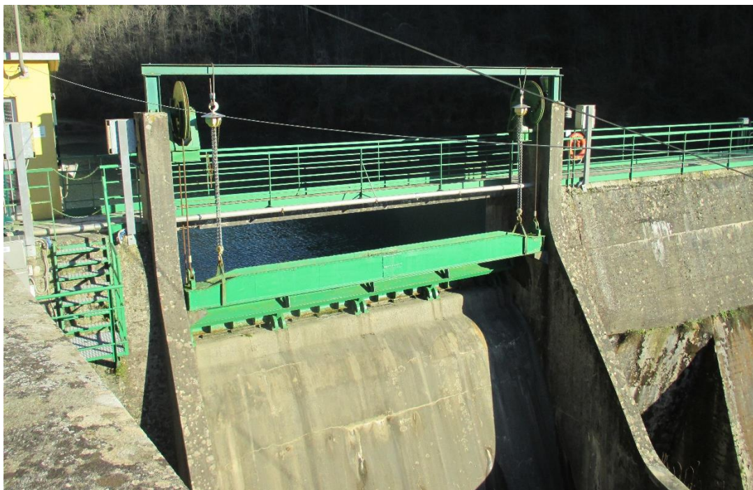
Figura 35 - Scarico di superficie, paratoia a ventola.
