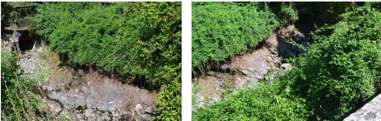
Figura 43 - affioramenti dello strato roccioso a monte dell'imbocco della galleria di by-pass.
