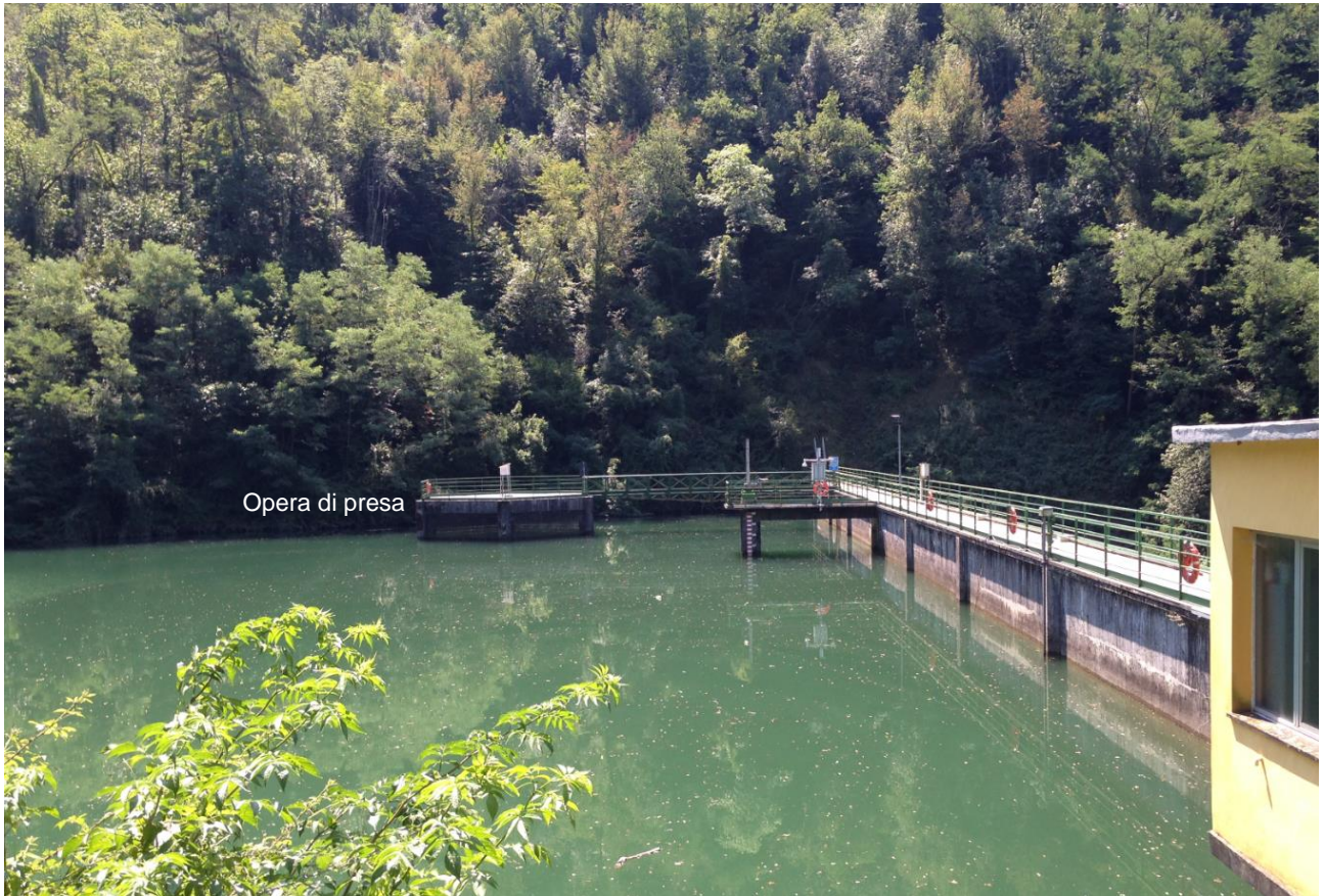
Foto 4 – Il corpo diga visto da monte con l'opera di presa.
