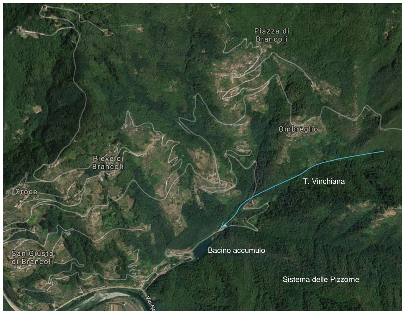
Figura 9 – Vista del bacino di accumulo sul Vinchiana.
