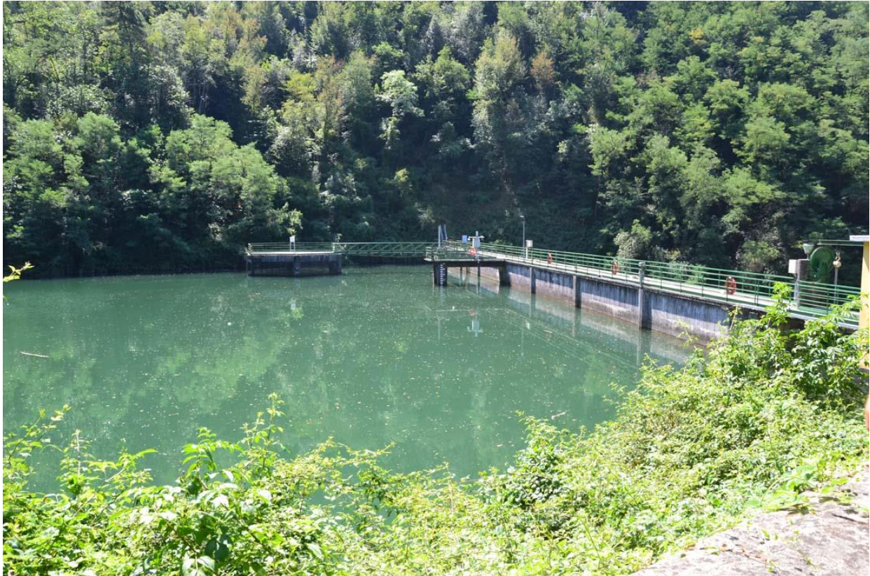
Figura 49 - Area a monte della diga: stato di fatto.
