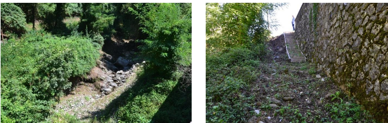
Figura 44: alveo del torrente Vinchiana a monte dell'imbocco del by-pass e gradinata in legno esistente.
