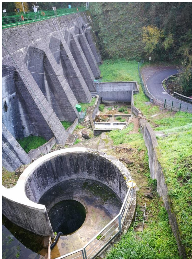
Figura 12 – Vista delle strutture in cemento armato del fronte diga.
