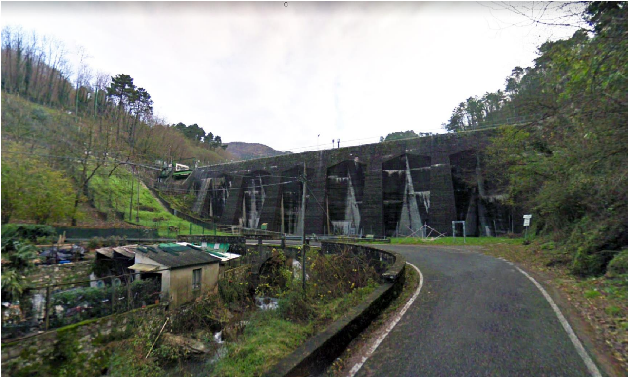
Foto 2 – Il corpo diga visto da valle.
