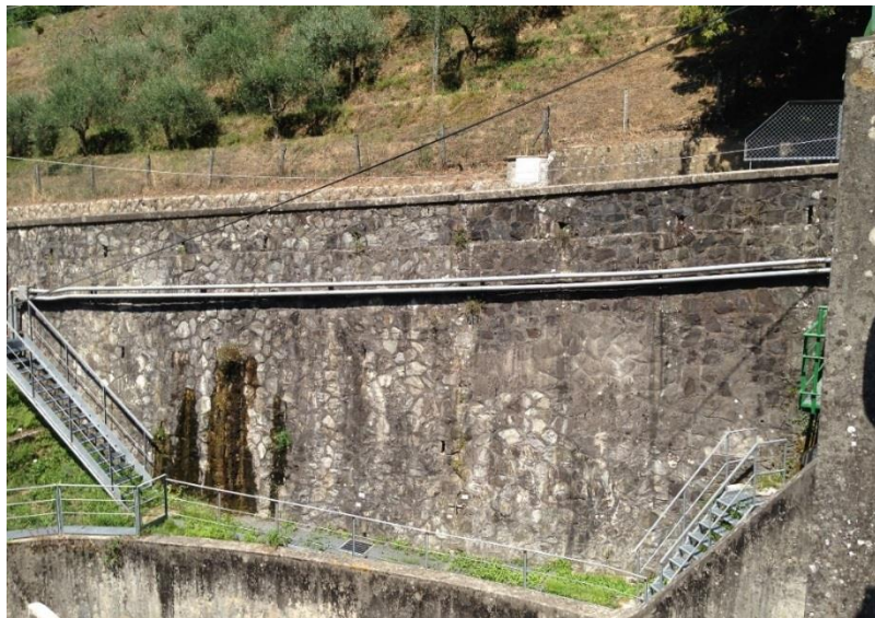
Figura 32 - Vista d'insieme del muro di sostegno della strada Brancoli.
