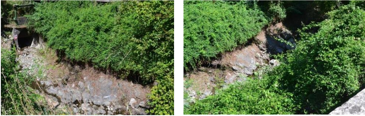
Figura 54 - Affioramenti dello strato roccioso a monte dell'imbocco della galleria di by-pass
