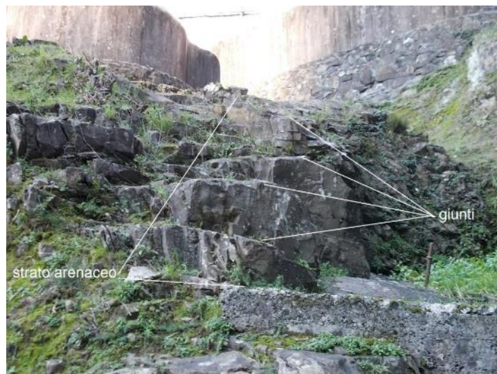
Figura 55 – Alternanze di arenarie e siltiti a valle delle vasche esistenti
