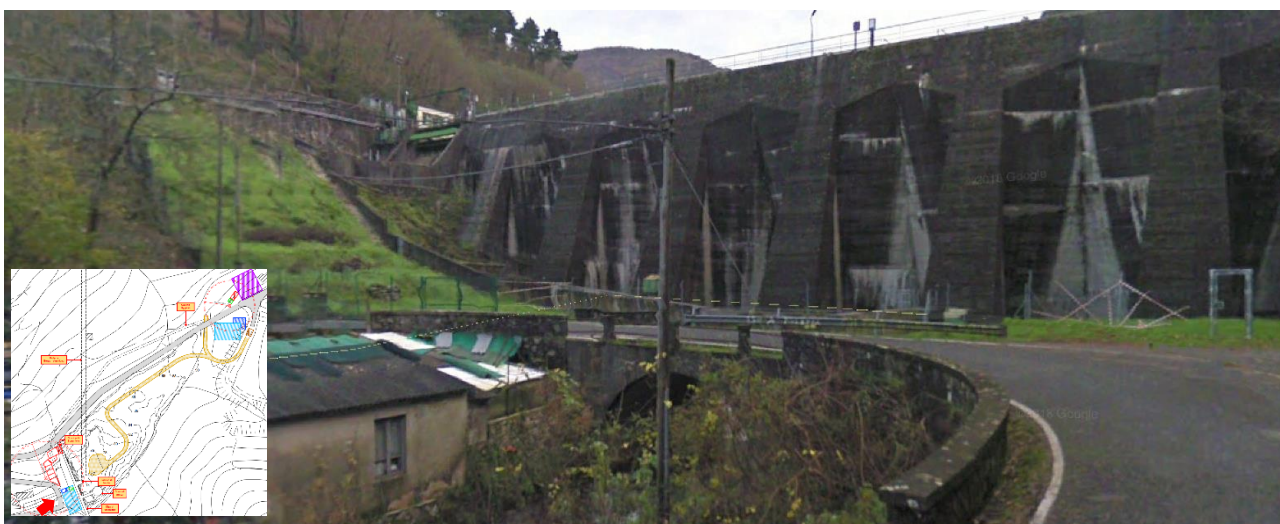
Figura 105. – Cantiere Lotto 2 – Zona interessate dal cantiere a valle dello sbarramento.
