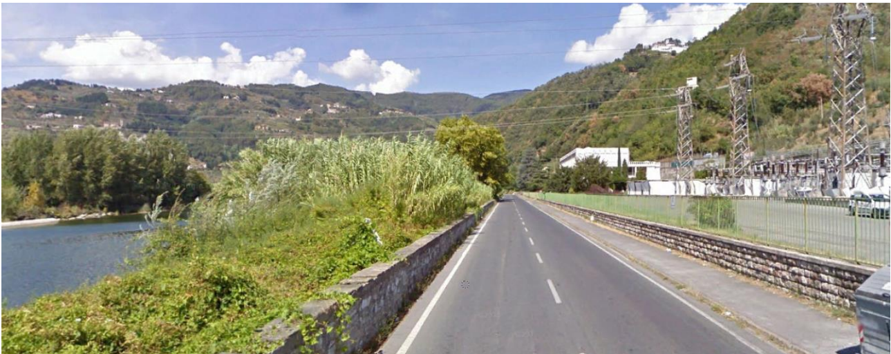
Figura 84 – Panoramica della zona della Centrale dalla via Nazionale, in direzione monte.
