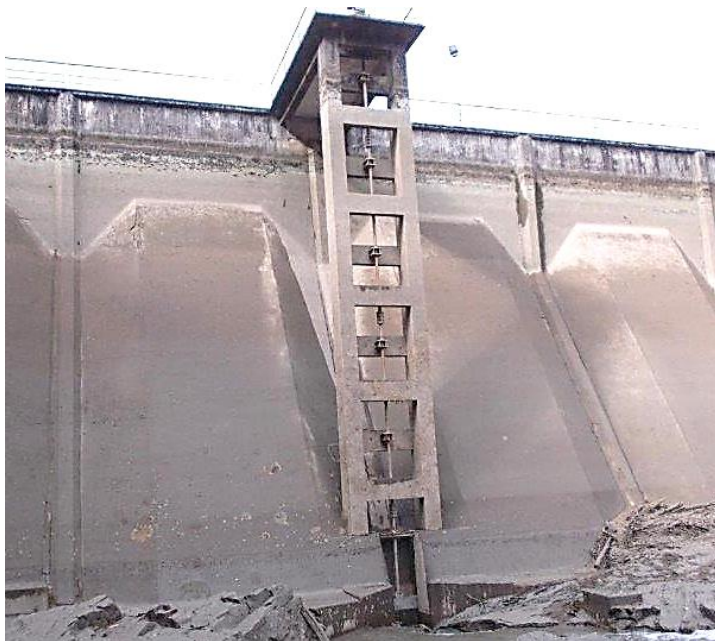
Figura 16 - Vista d'insieme dello scarico di fondo e dettaglio della paratoia
