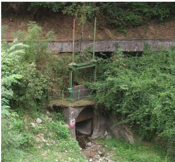
Figura 19 - Situazione esistente con paratoia e assonometria del nuovo manufatto di imbocco
