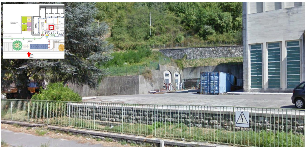
Figura 102. – Cantiere Lotto 1 – Zona interna all'area di pertinenza della Centrale.
