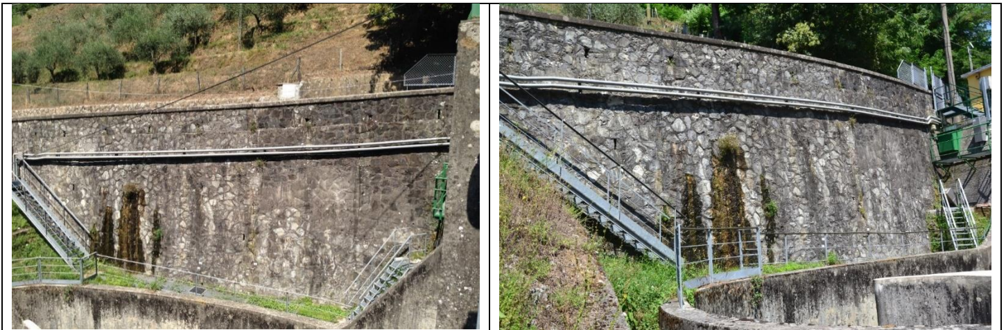
Figura 9: vista d'insieme e da valle del muro di sostegno della strada Brancoli
