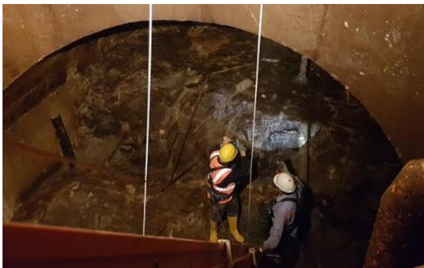
Figura 60 – Fronte di scavo attuale del tratto di galleria di scarico
