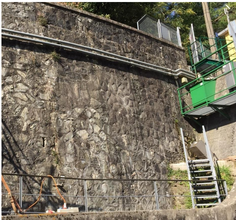
Figura 10: dettaglio del muro di sostegno della strada Brancoli
