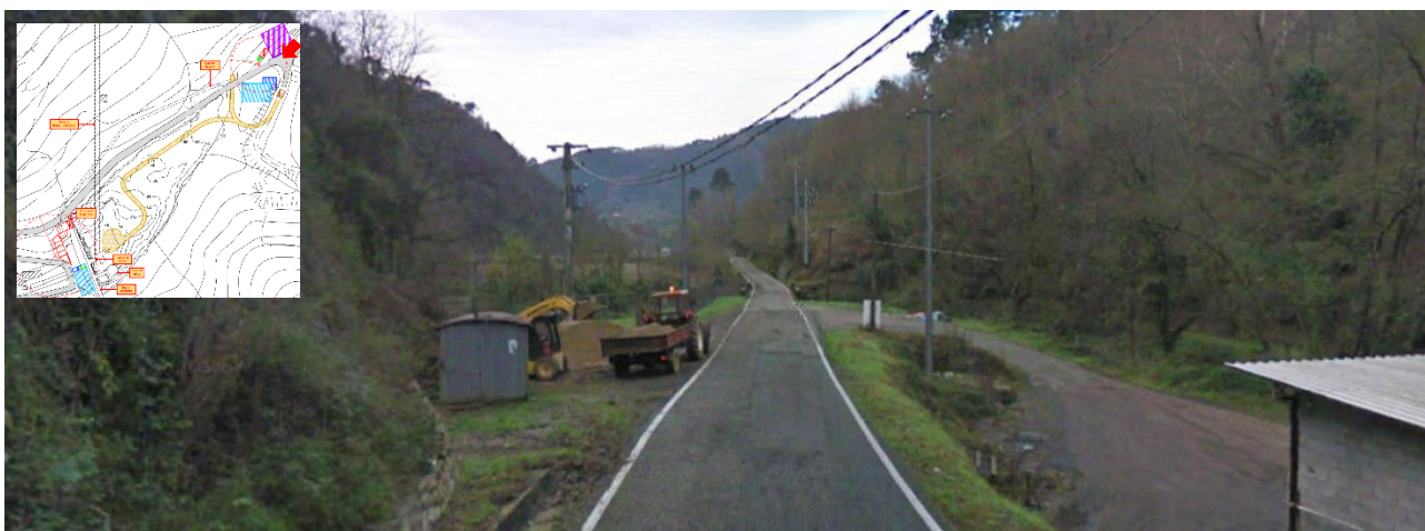
Figura 103. – Cantiere Lotto 2 – Zona interessata dal cantiere a monte del bacino.
