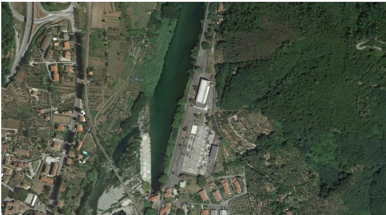
Figura 83 – Vista della zona della Centrale.
