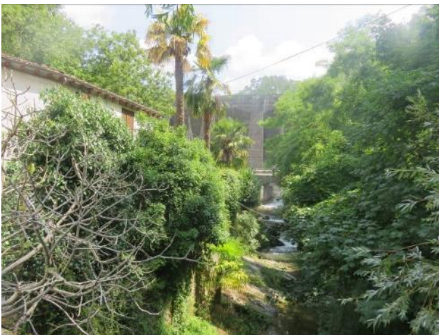
Figura 69 - Foto del torrente a valle del ponte su Via Brancoli
