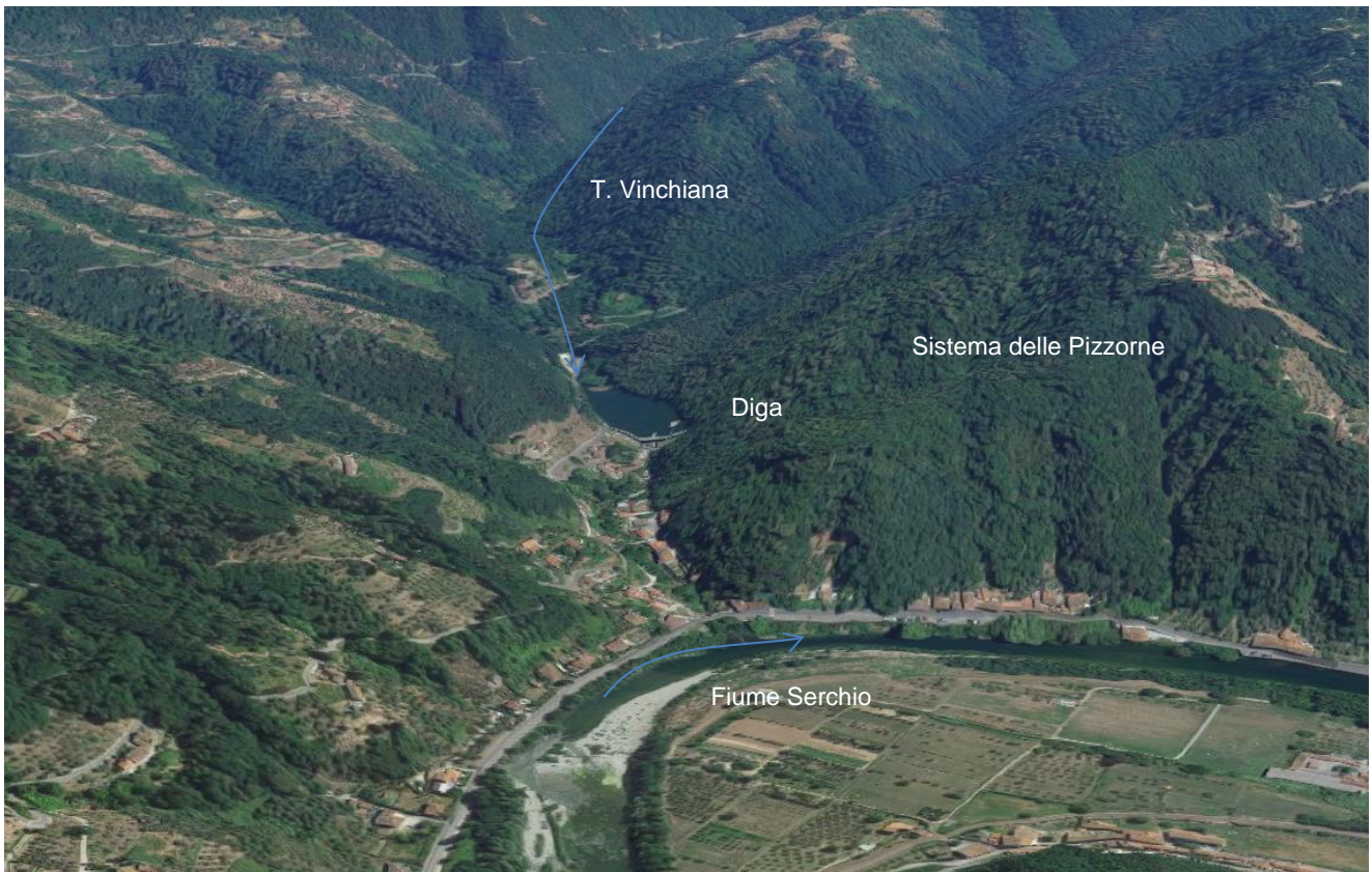
Figura 85 – Vista della valle del Vinchiana e dell’omonimo sbarramento.
