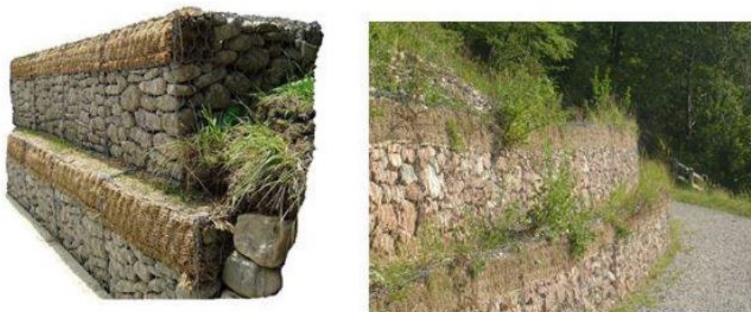
Figura 13 - Esempi di gabbionate con tasche vegetative rinverdibili
