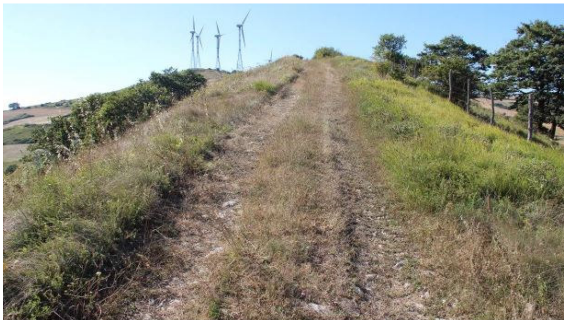
Figura 11 - Pista esistente di collegamento tra la postazione dell'aerogeneratore R-M02 e R-MA03 da adeguare
