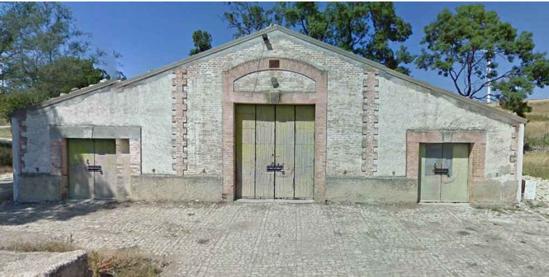
FABBRICATO N.1 - FOTO STATO DEI LUOGHI
