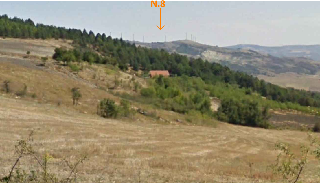
FABBRICATO N.8 - FOTO STATO DEI LUOGHI
