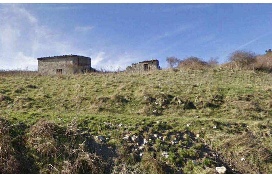
FABBRICATO N.6 - FOTO STATO DEI LUOGHI
