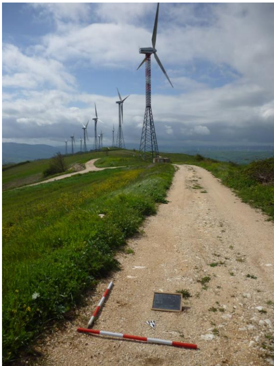
Viabilità esistente e impianti eolici da dismettere in Località Montagna, Montaguto (Av).
