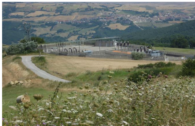
Stazione Elettrica Celle S.Vito (Fg), Località Valle Cupa.
