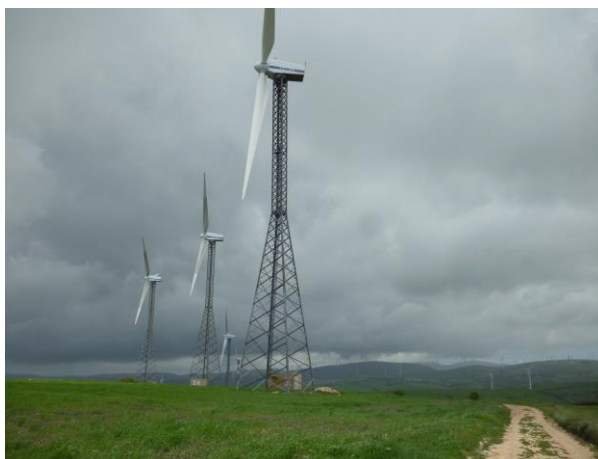
Viabilità esistente e impianti eolici da dismettere in Località Monte Rovitello, Greci (Av).
