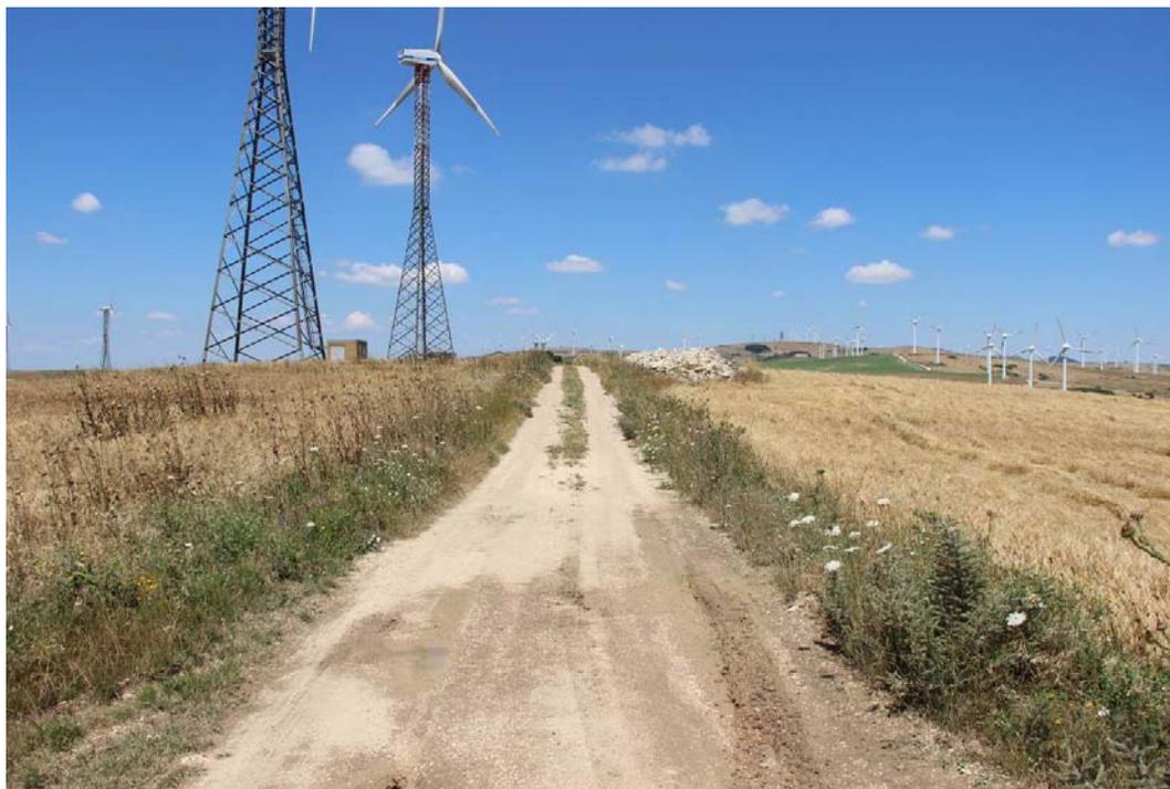
**Figura 4:** tratto di strada che serve l'impianto esistente in prossimità della nuova posizione R-GR06: la strada avrà bisogno esclusivamente di interventi minimi di allargamento della sede carrabile e di ricarica puntuale con stabilizzato di cava.
