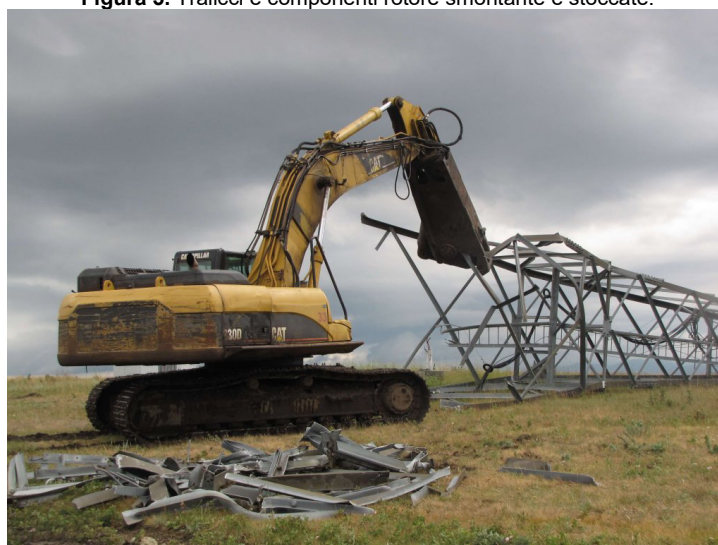
Figura 6. Mezzi cingolati che tagliano le sezioni della torre in acciaio per un trasporto più semplici ed efficienti fuori sede.
