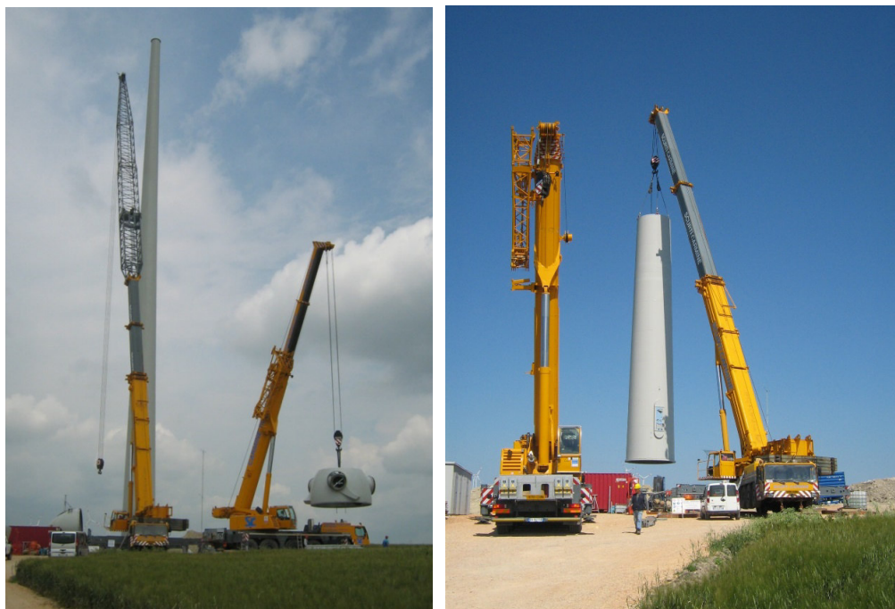
Figura 9: smontaggio navicella
