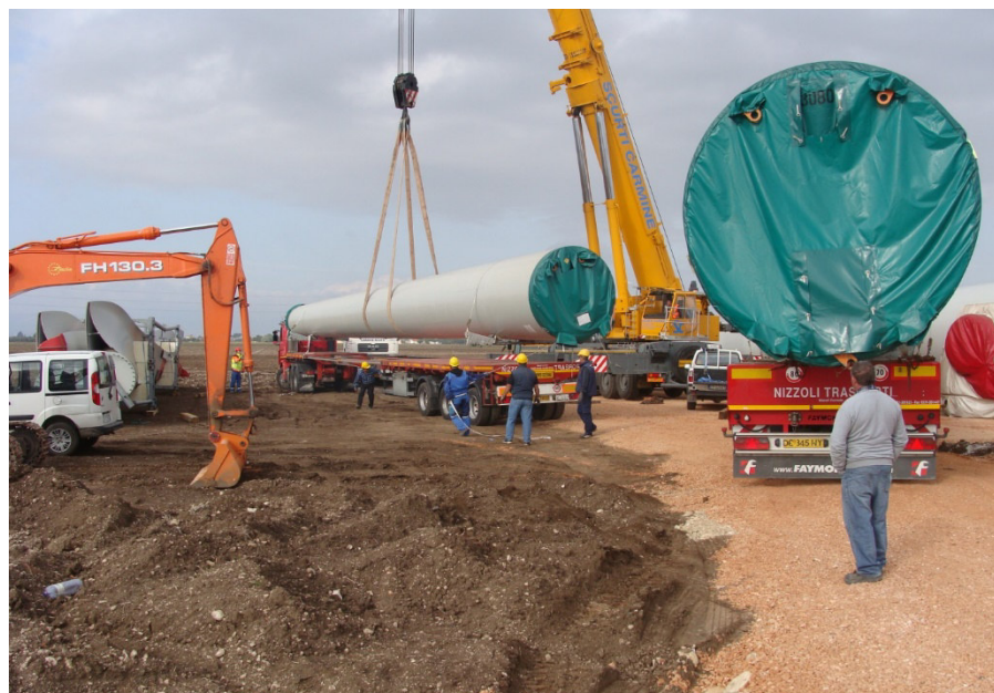
Figura 11: elementi torre smontata pronti per il trasporto
