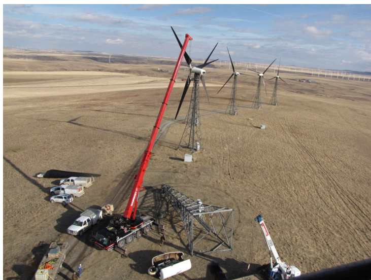
Figura 4. Smontaggio traliccio
