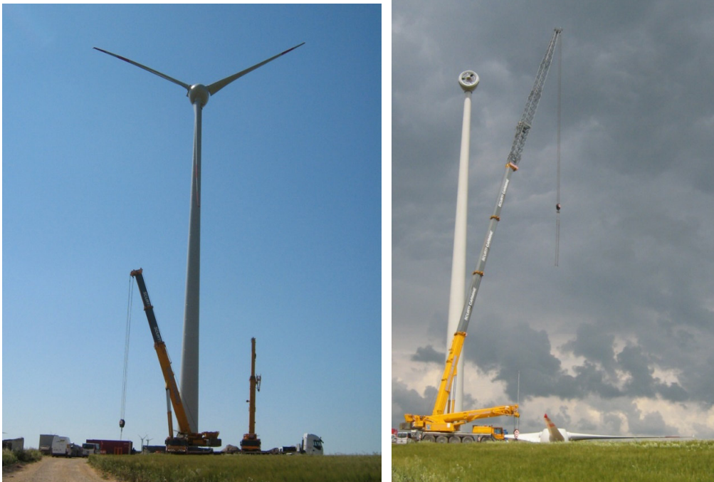
Figura 8: rimozione eliche e mozzo
