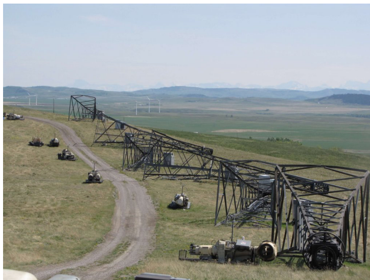
Figura 5. Tralici e componenti rotore smontante e stoccate.
