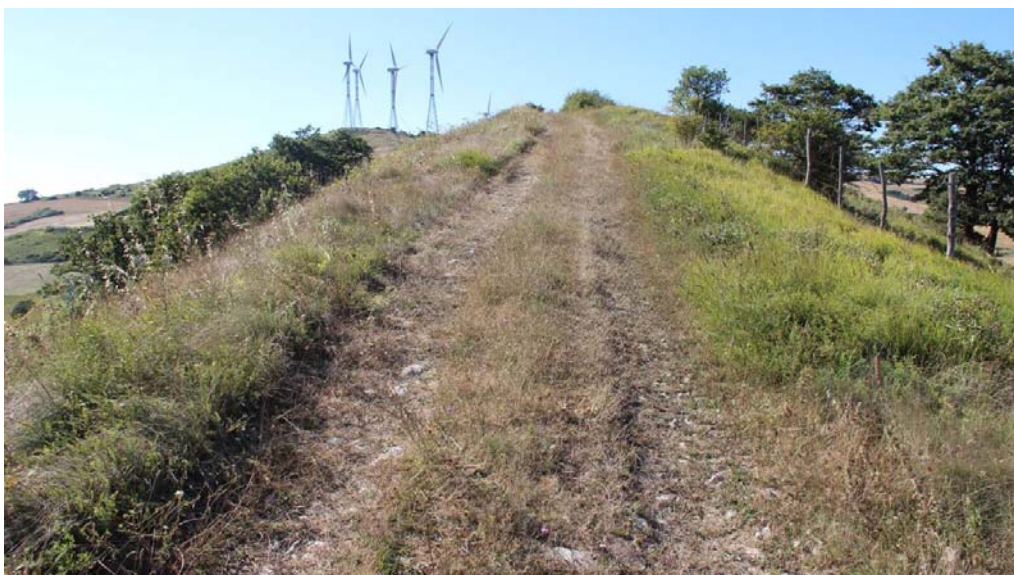
Figura 8: tratto di strada esistente di collegamento tra la postazione dell'aerogeneratore R-MA02 e R-MA03. La strada andrà realizzata ex novo.
