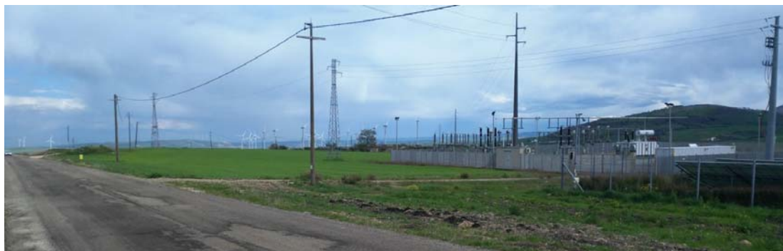
Figura 6 – l'area di ubicazione delle opere di connessione del lotto di impianto di Greci, ricadente in agro di Troia, è interessata da una importante stazione elettrica 380 kV di Terna oltre che da diverse sottostazioni di utenza, impianti eolici e impianti fotovoltaici.
