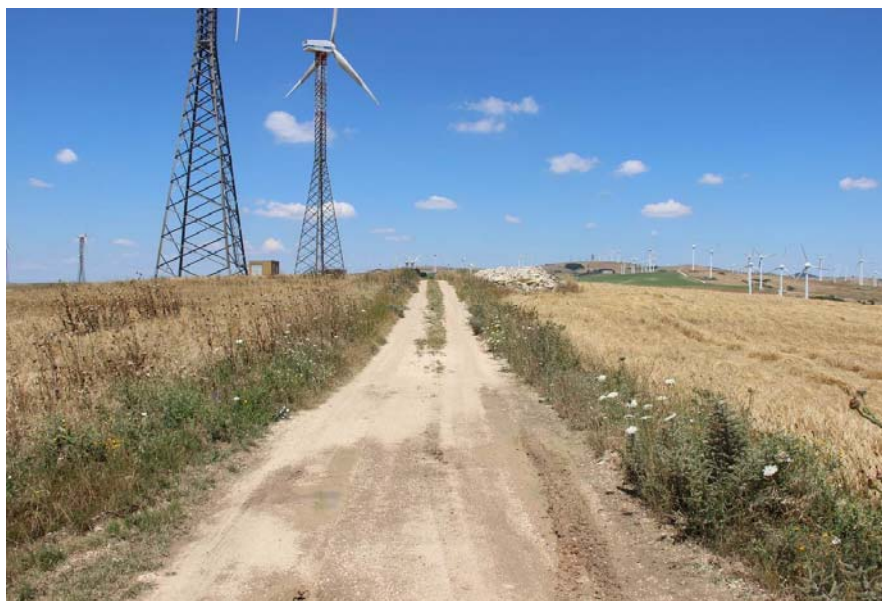
Figura 9: tratto di strada che serve l'impianto esistente in prossimità della nuova posizione R-GR06: la strada avrà bisogno esclusivamente di interventi minimi di allargamento della sede carrabile e di ricarica puntuale con stabilizzato di cava.
