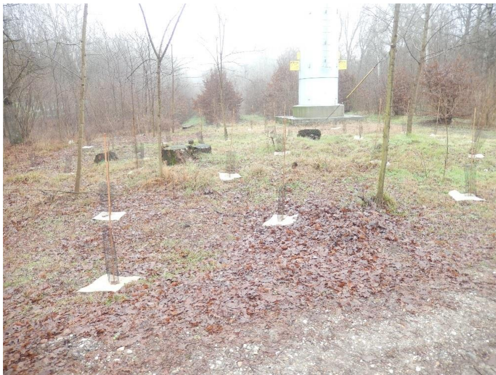
Figura 62 - Interventi di ripristino nel Parco naturale della valle del Ticino sulla linea 380 kV Trino-Lacchiarella
