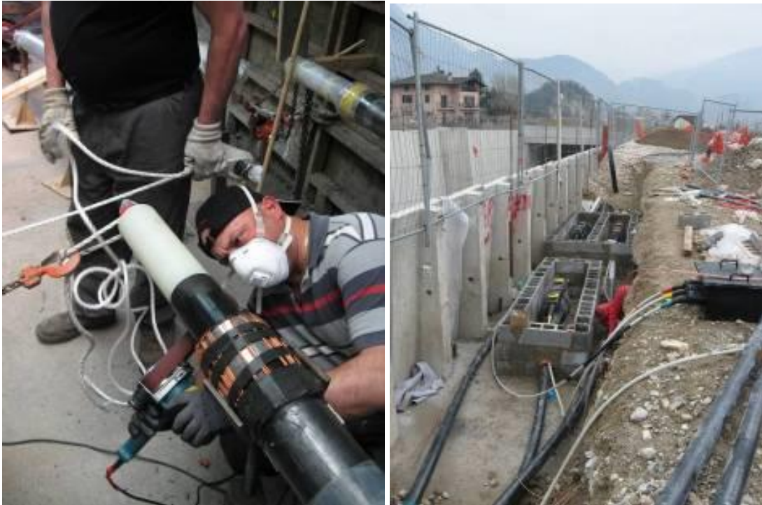
Figura 51 - Esecuzione giunto esempio di buca giunti
