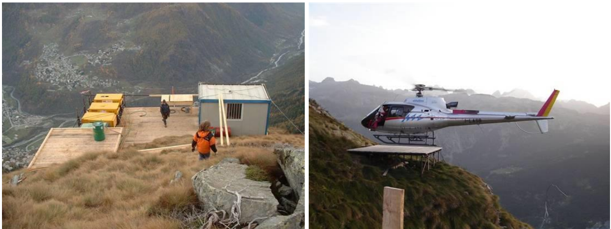
Figura 30 - Esempi di micro - cantieri in quota
