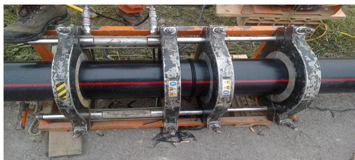
Figura 47 - Particolare saldatura tubazioni PEAD
