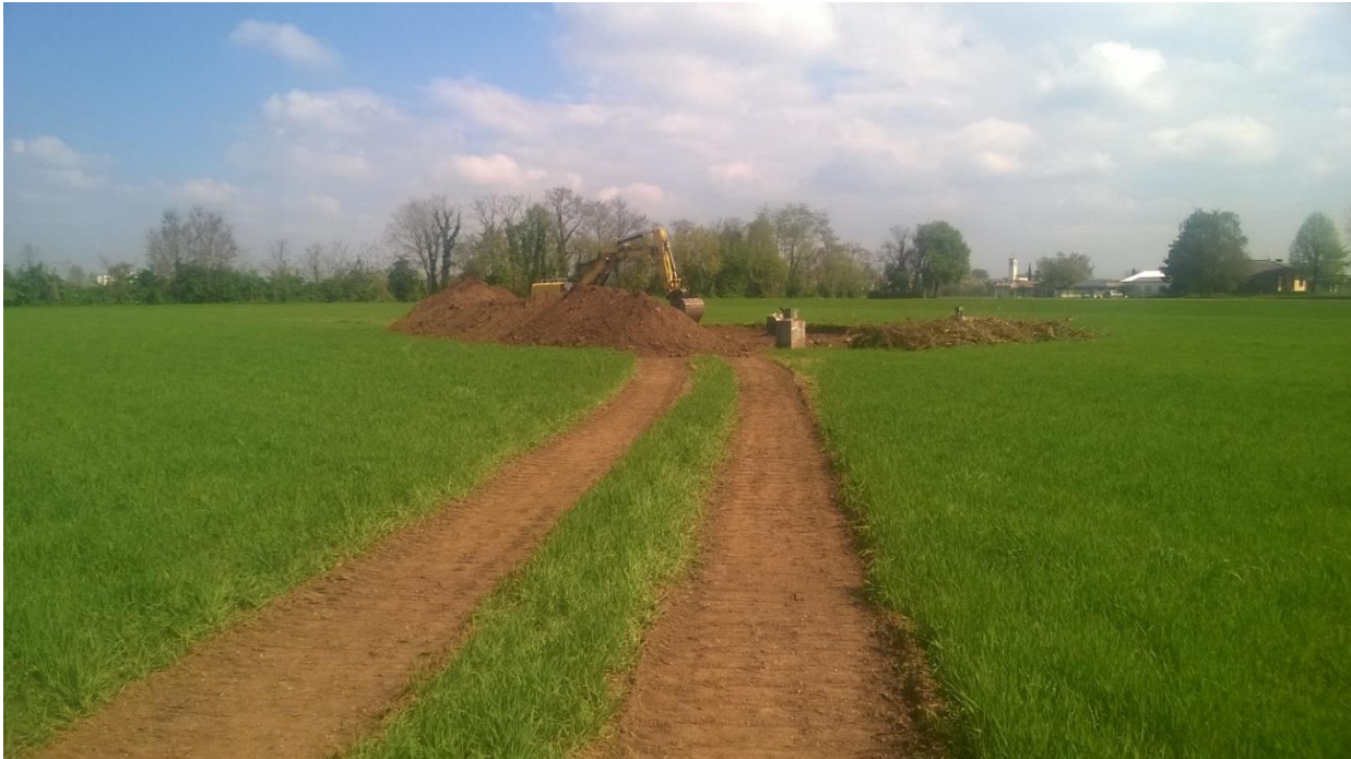
Figura 59 - Esempio di pista temporanea su terreno agricolo
