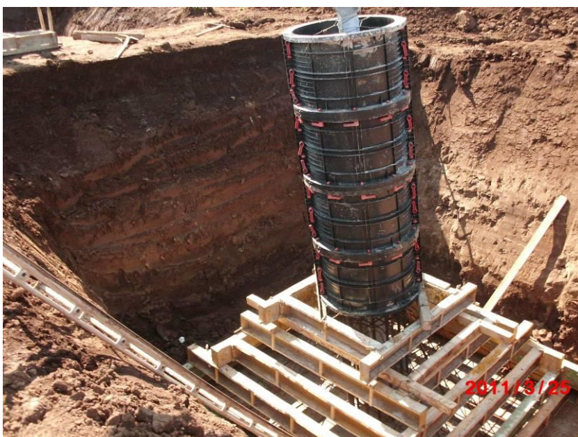
Figura 12 - Realizzazione di fondazioni superficiali tipo CR per un sostegno a traliccio. Nell'immagine si può osservare la fase di casseratura
