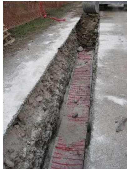
Figura 44 - Rinterro con posa delle piastre di protezione e rete in PVC
