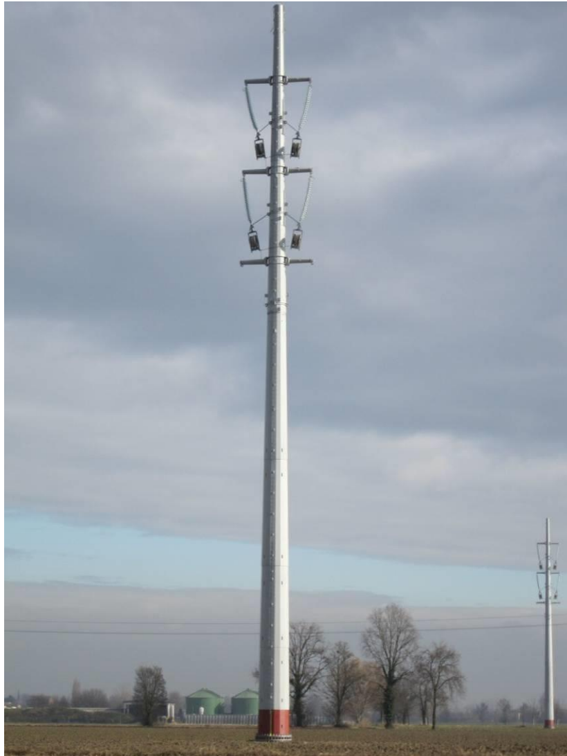
Figura 19 - Sostegno monostelo montato. Si notino le carrucole collegate alle catene degli isolatori, fase che precede la “tesatura” dei conduttori
