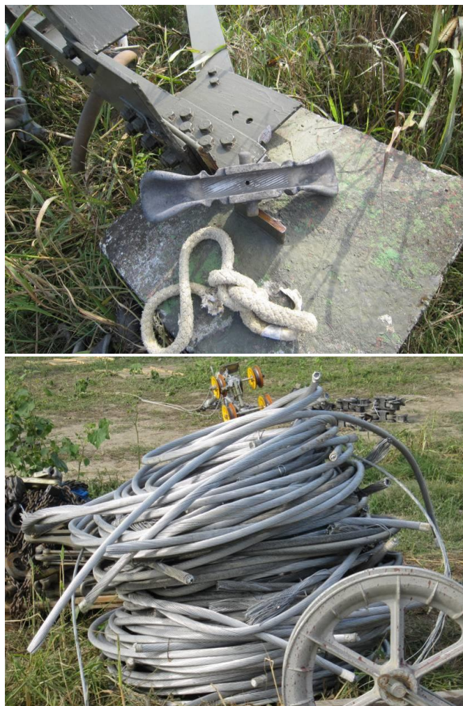
Figura 56 - Fasi demolizione di un sostegno a traliccio, particolare di materiale raccolto
