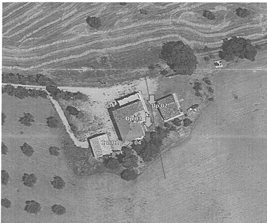
Figura 13. Ubicazione delle prove in sito
