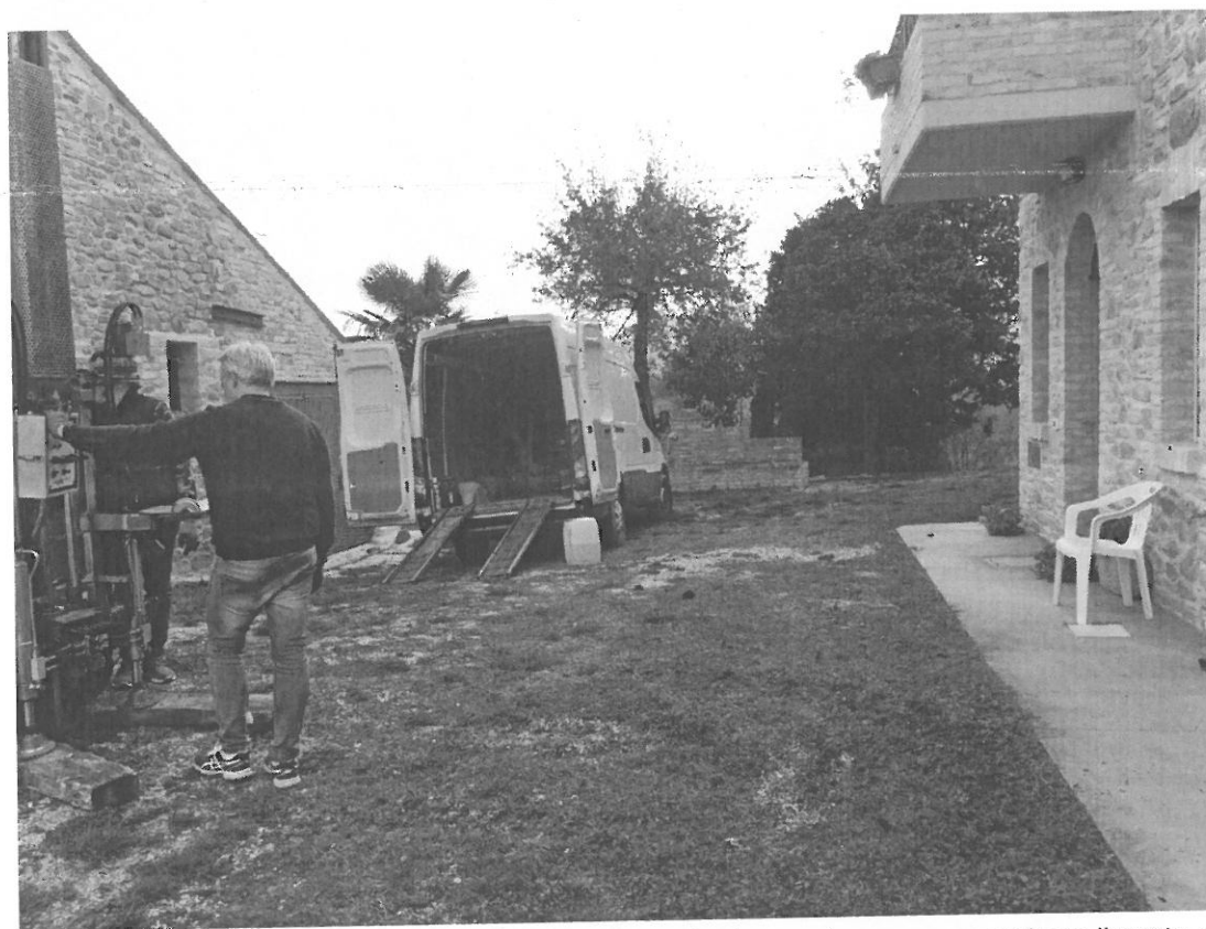
Figura 12. Punto di esecuzione di una delle prove in sito, in questo caso per verificare il punto di passaggio tra i terreni di riporto e le argille del substrato
