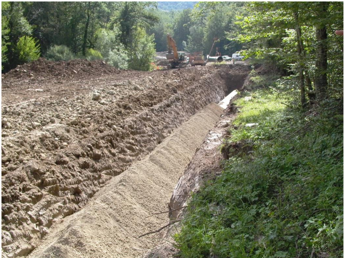
Figura 9.9-1 – Rinterro della condotta
