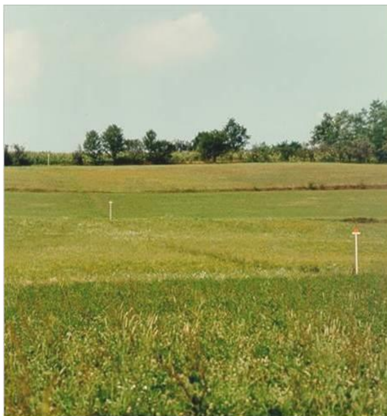
Figura 13/A – Pista lavori a ripristini ultimati su un gasdotto in esercizio
