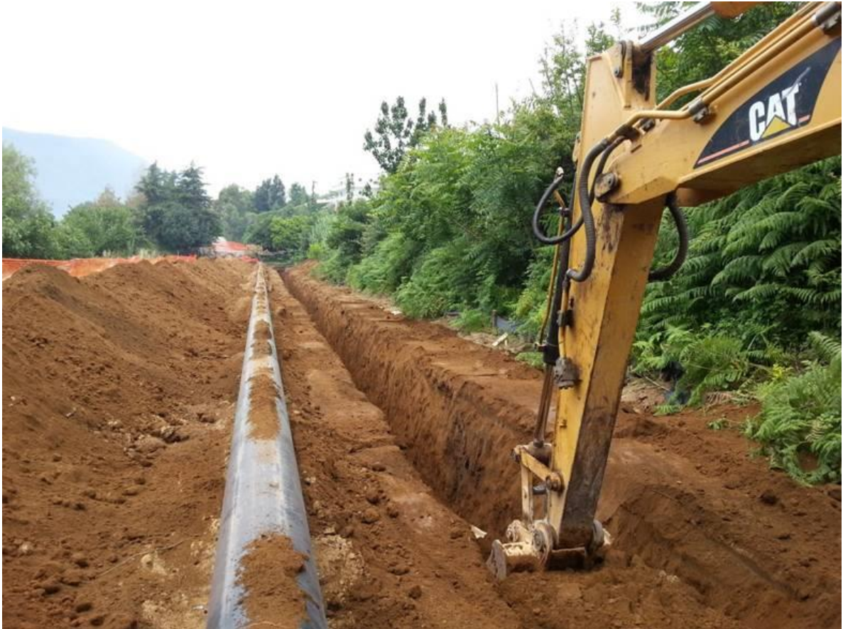
Figura 13/A – Scavo della trincea
