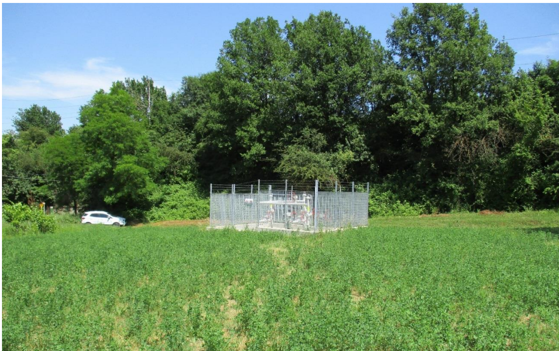
Figura 15.2-1 – Esempio impianto PIDI da dismettere.
