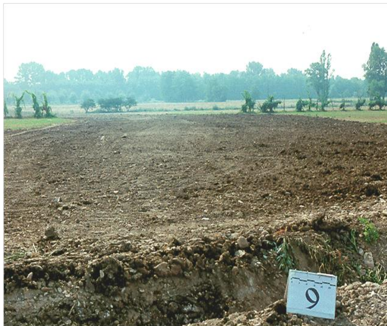
Figura 13/B – Rinterro della condotta
