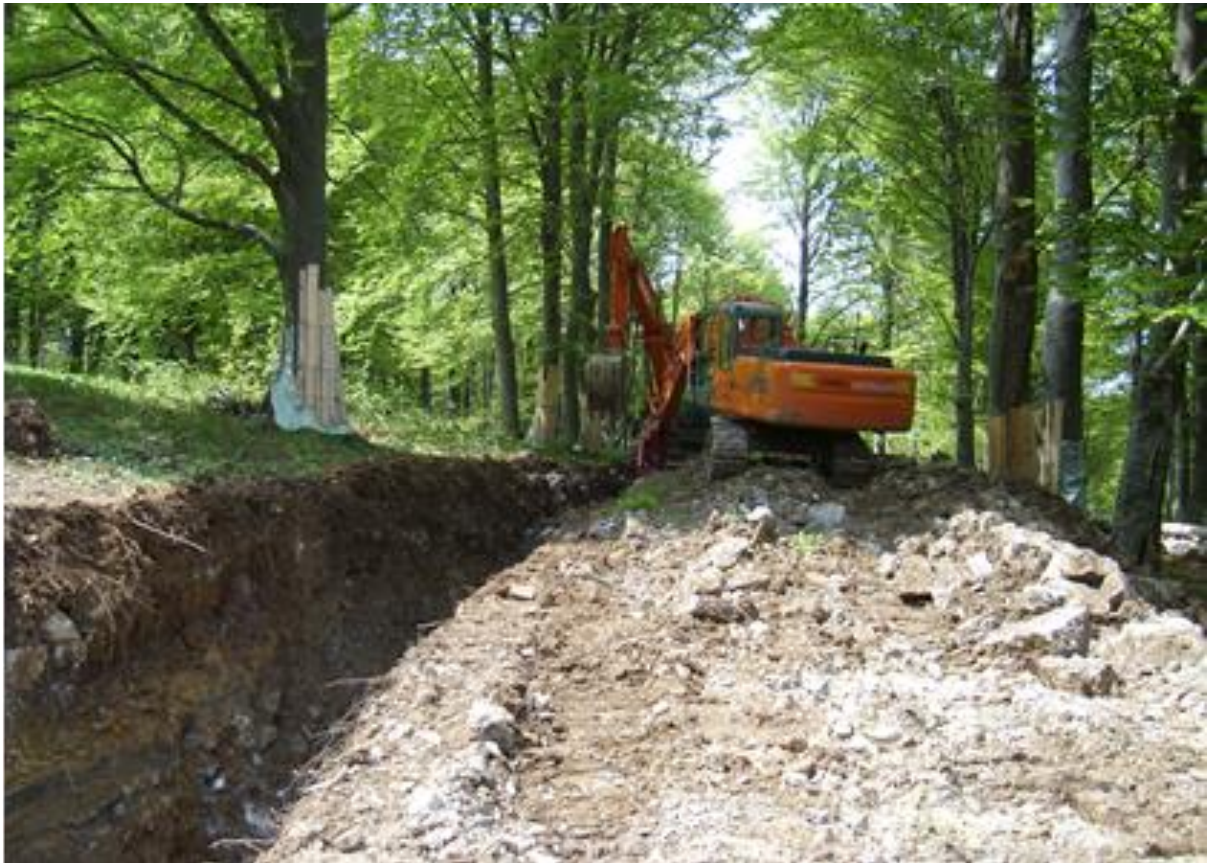
Figura 9.6-1 – Scavo della trincea
