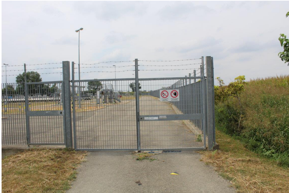
RP-7 AREA INGRESSO INTERVENTO 1 – TRAPPOLA N. 475 DI ALESSANDRIA
