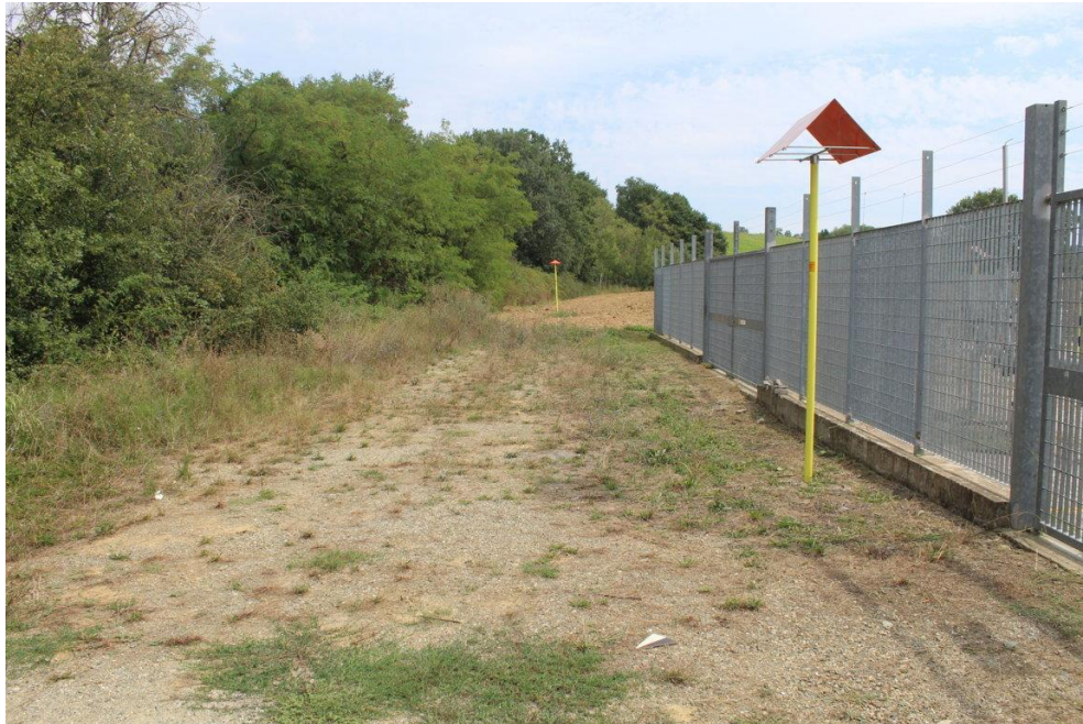
RP-15 AREA LATERALE INTERVENTO 2 – RIF. PIDI 4500240/4.1
