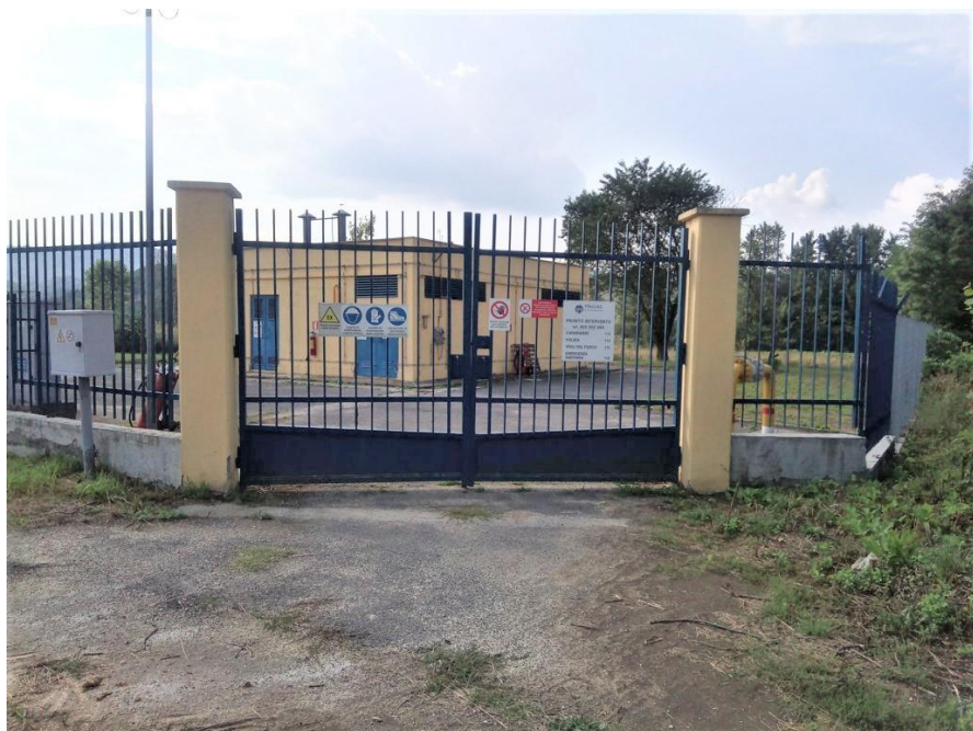
RL-6 – ACCESSO IMPIANTO A DISTANZA DALL'INTERVENTO 6 – RIF. PIDI 4500240/33
