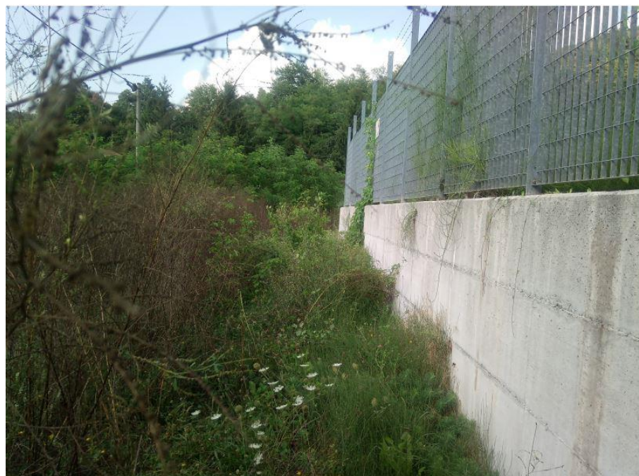
RL-12 LATO SBANCAMENTO INTERVENTO 7 – RIF. PIDI 4500240/36
