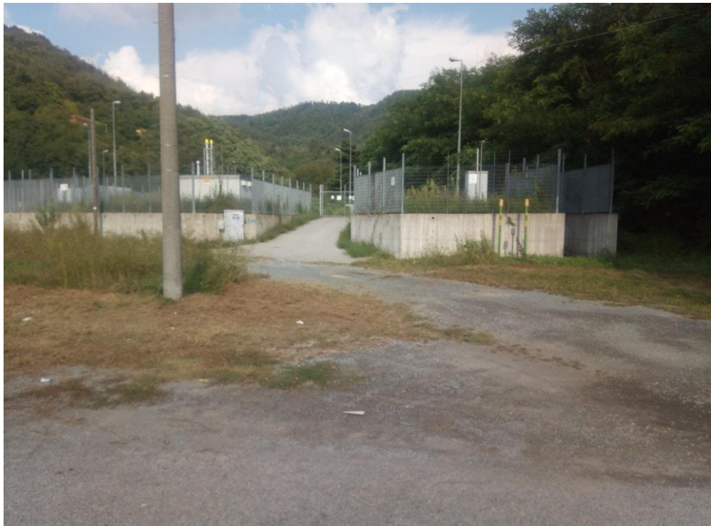
RL-10 – STRADA DI ACCESSO INTERVENTO 7 – RIF. PIDI 4500240/36
