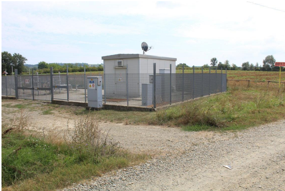
RP-12 AREA INTERVENTO 2 – RIF. PIDI 4500240/4.1
