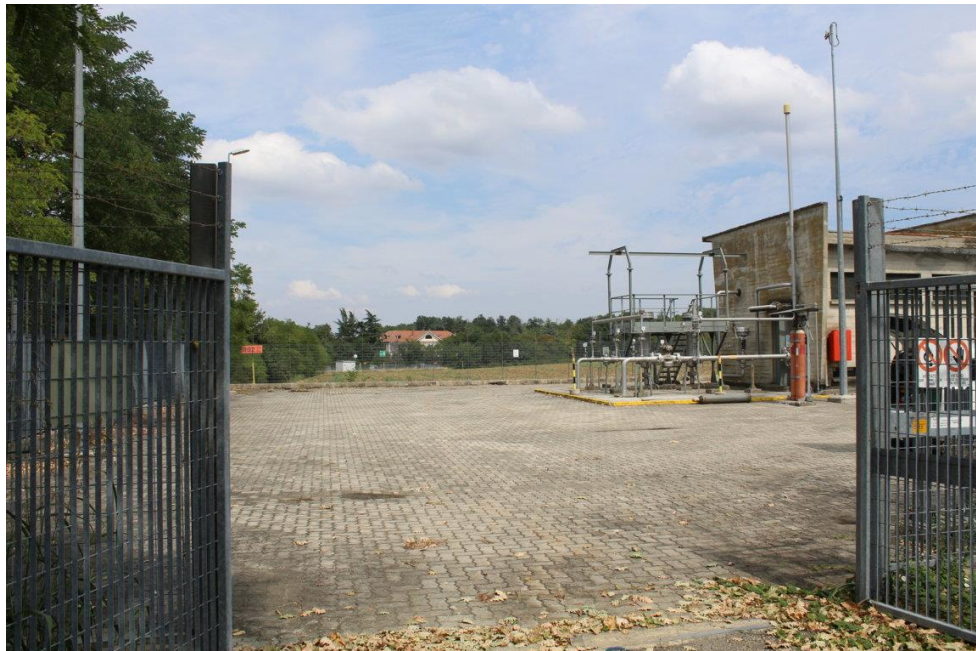
RP-16 INGRESSO IMPIANTO VICINO AD INTERVENTO 2 – RIF. PIDI 4500240/4.1
