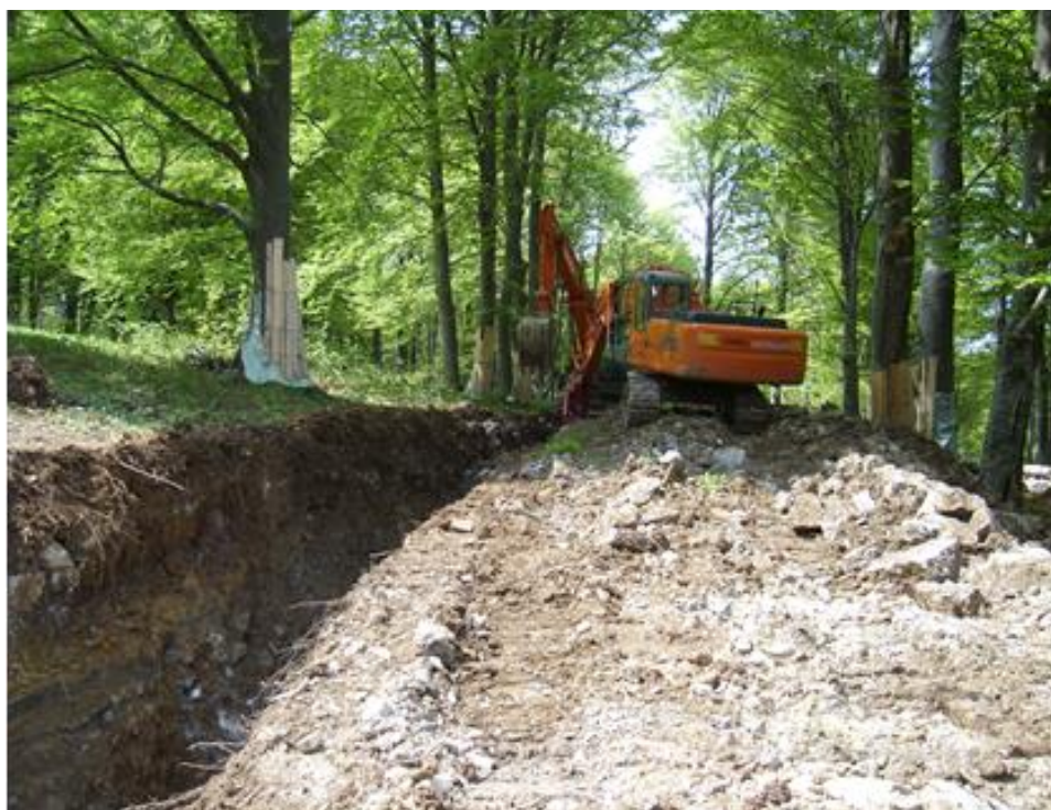
Figura 4-2 – Scavo della trincea
