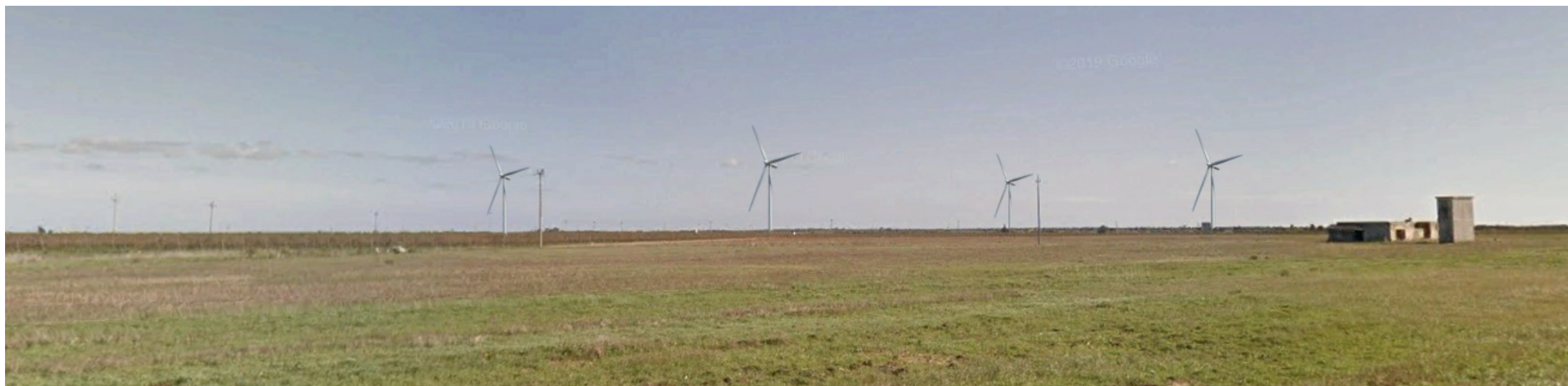
VISUALE 03 - POST OPERAM Segnalazione architettonica Masseria Uggio
