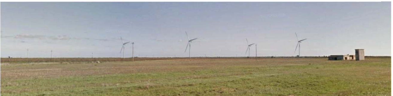
Figura 3-5: Panoramica ante e post opera dalla segnalazione architettonica Masseria Uggio
