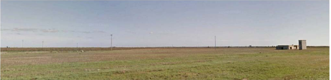
VISUALE 03 - POST OPERAM Segnalazione architettonica Masseria Uggio
