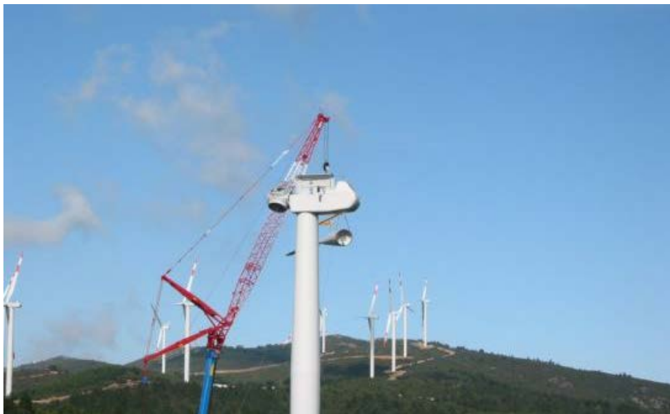
Figure 4-12: posa in opera degli aerogeneratori
