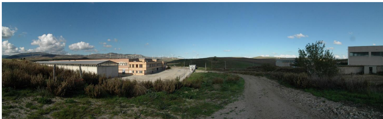
Stato di fatto – Punto di presa fotografica 7
