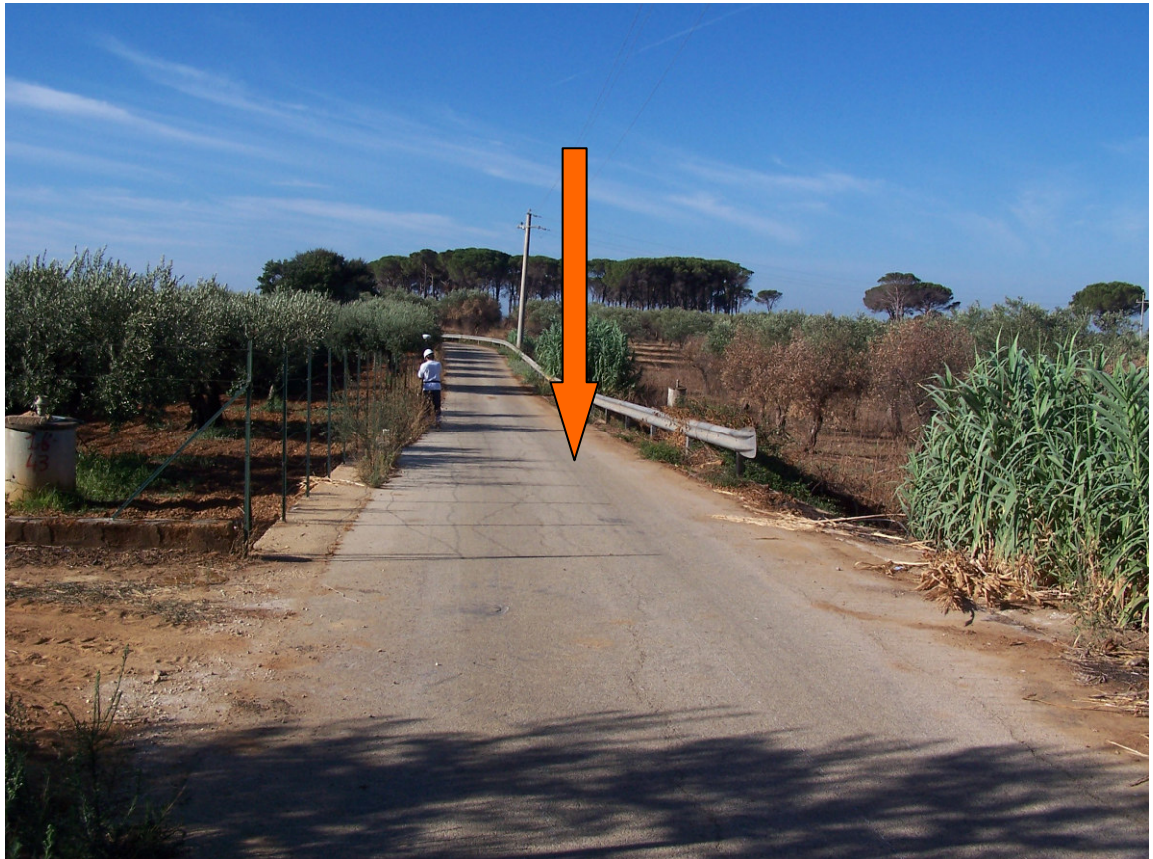
Foto con individuazione canalizzazione sotto viabilità
