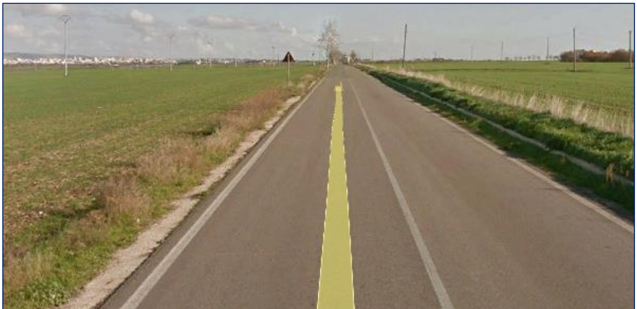
Figura 2-11: SP 25 verso l'aerogeneratore n. 5
