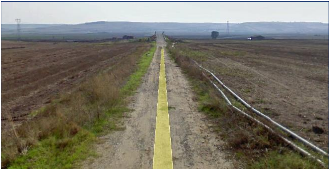
Figura 2-12: strada interpodereale interna agli aerogeneratori
