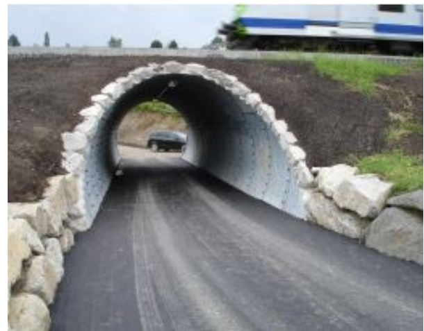
Figura 7 - Rappresentazione grafica del tombino con tubazione circolare Armco
