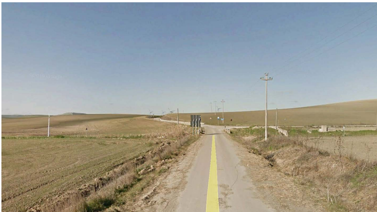
Figura 23-13: Panoramica dal Punto 05 – post opera
