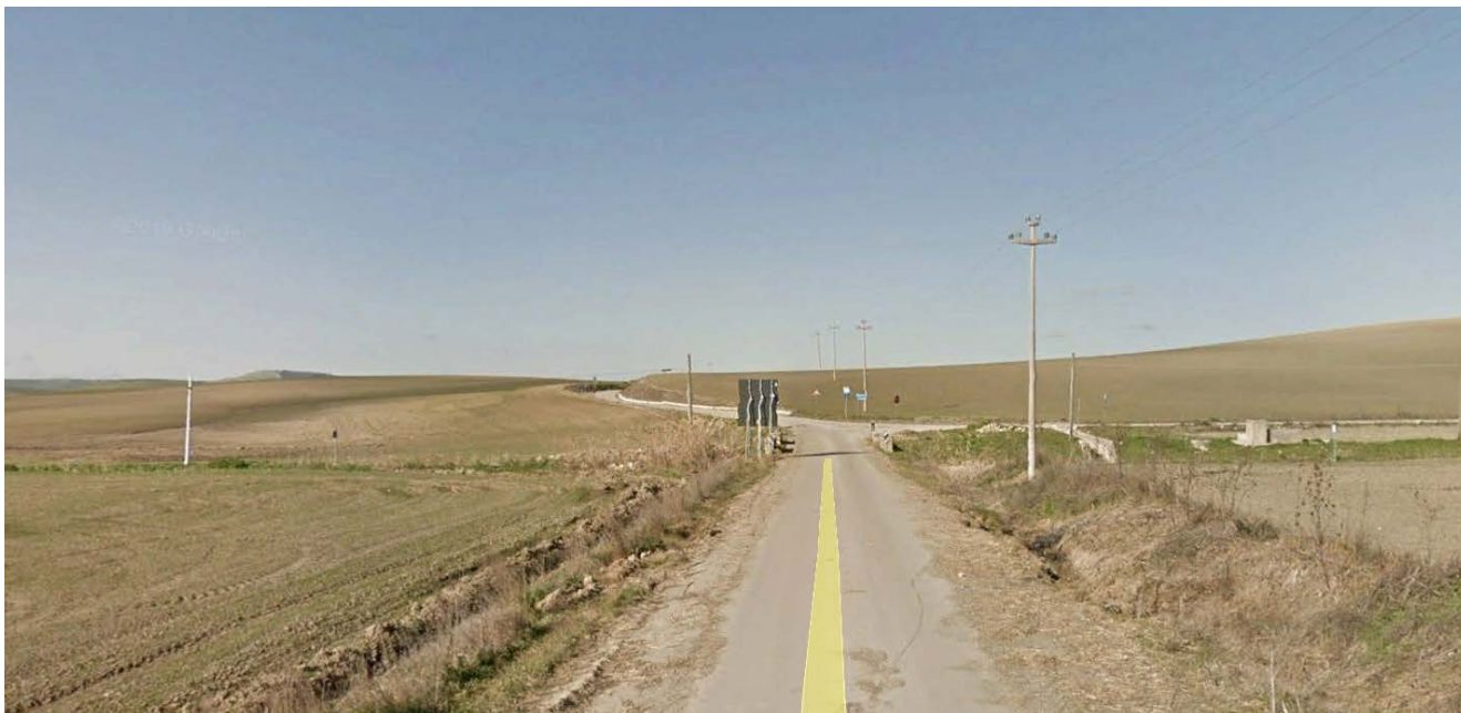
Figura 6-31: Panoramica dal Punto 05 – ante opera
