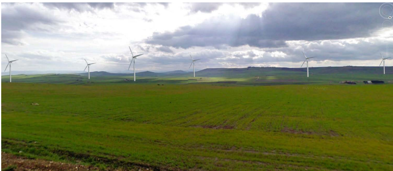
Figura 6-26: Panoramica dal Punto 02 – post opera
