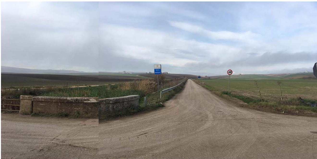
Figura 6-33: Panoramica dal Punto 06 – ante opera
