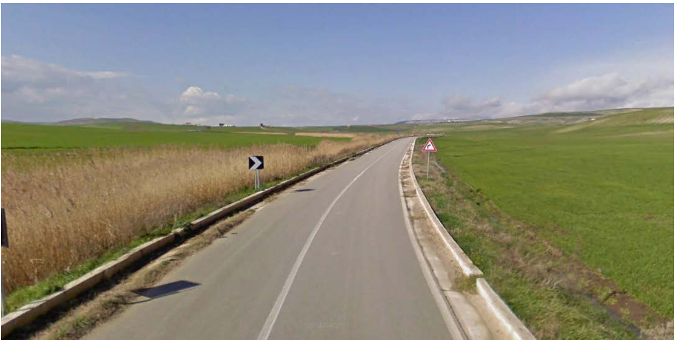
Figura 6-8: SP 8 verso l'area del parco eolico
