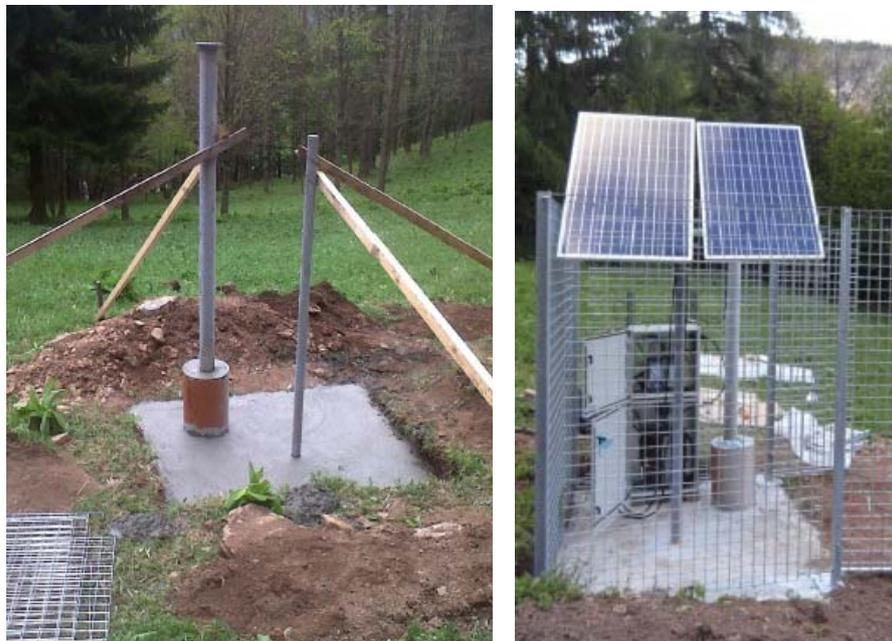
Figura 31 - Installazione tipo sensore con postazione alimentazione
