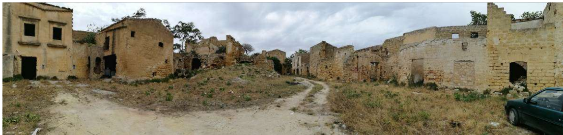
Figura 7: zona di edifici colpiti da terremoto adiacenti la chiesa di San Giuseppe
