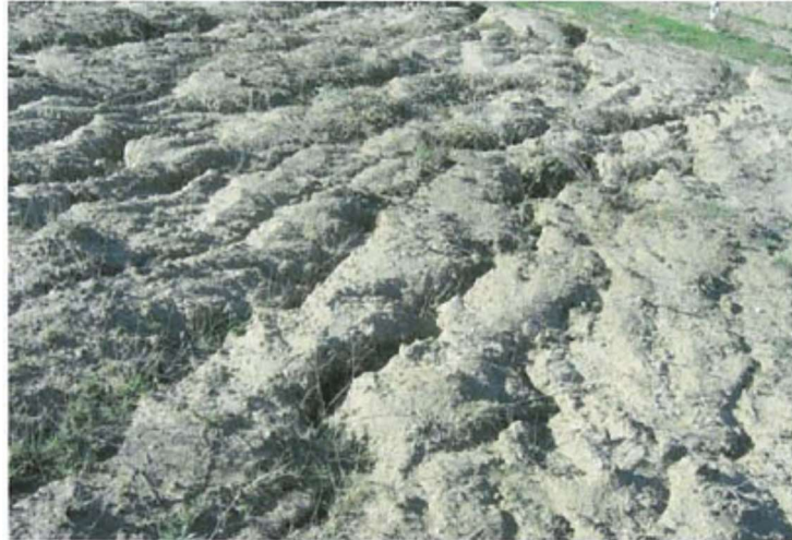
Figura 8 Forme erosive sulla sponda destra dell'invaso del Rendina (Potenza)
