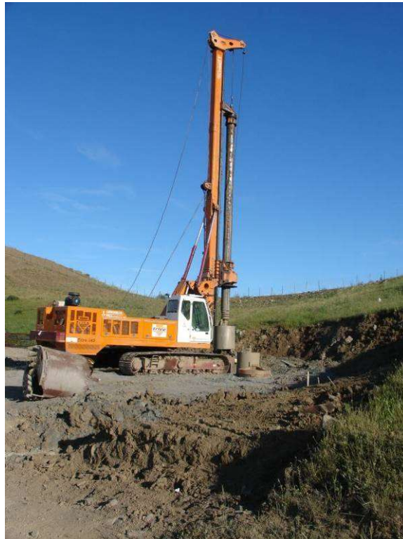
Figura 18 esecuzione dei pali di fondazione di un aerogeneratore.
