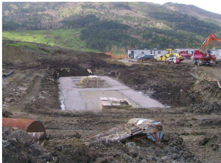
Figura 19 fondazione e realizzazione edificio utente entro area sottostazione.
