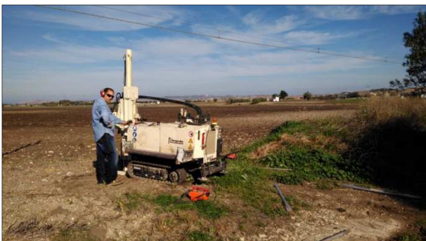
Postazione Sondaggio S6arx
