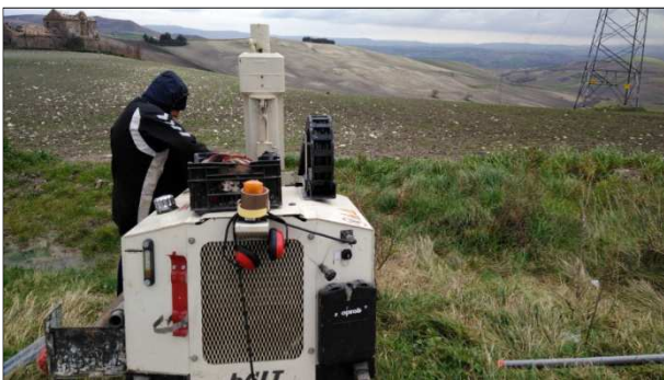
Postazione Sondaggio S7ax
