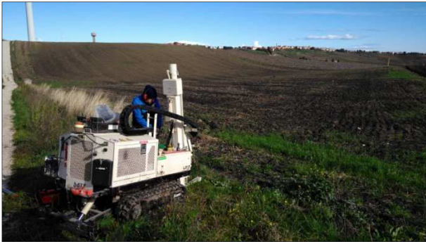
Postazione Sondaggio S4arx
