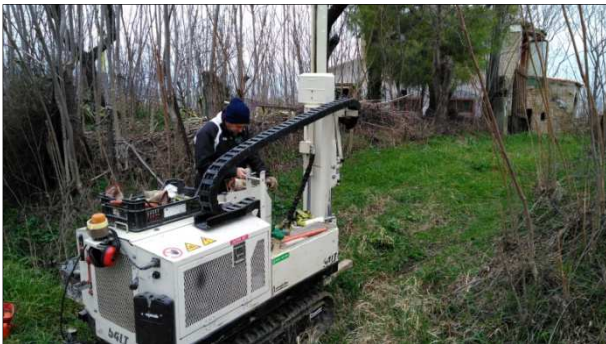
Postazione Sondaggio S10ax
