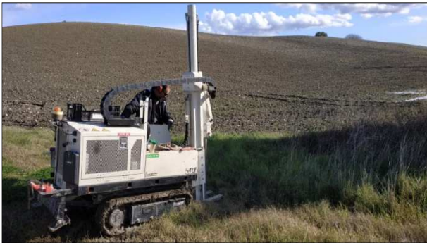
Postazione Sondaggio S6ax
