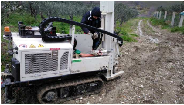
Postazione Sondaggio S1ax
