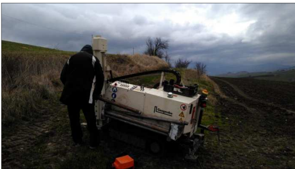
Postazione Sondaggio S2arx
