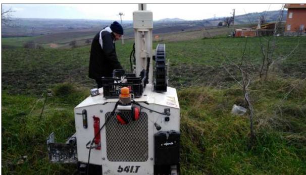
Postazione Sondaggio S3arx
