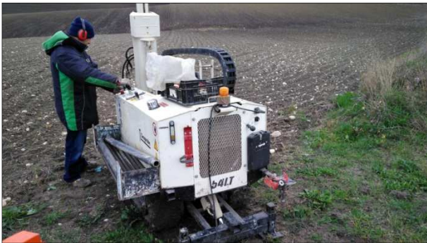
Postazione Sondaggio S13ax
