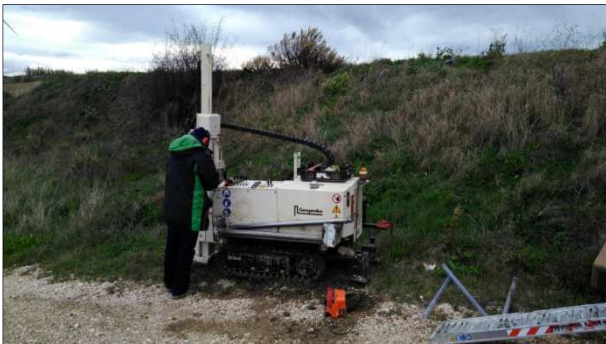
Postazione Sondaggio S14ax
