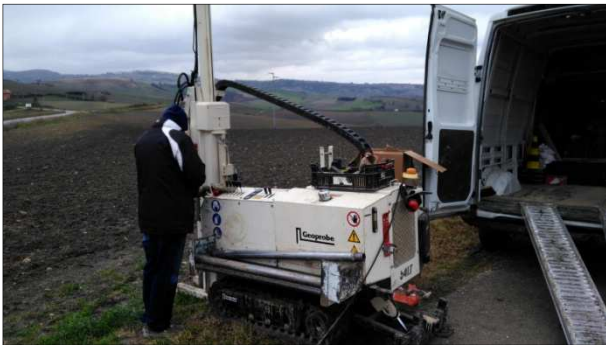
Postazione Sondaggio S9ax
