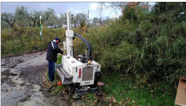
Postazione Sondaggio S1arx
