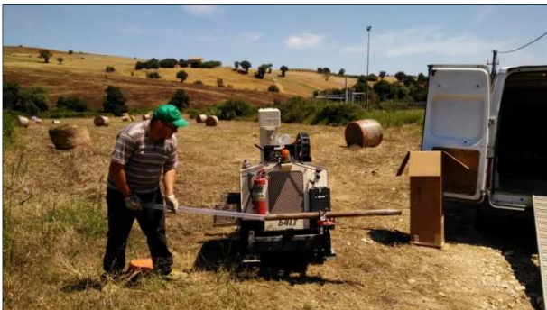
Postazione Sondaggio S3ax
