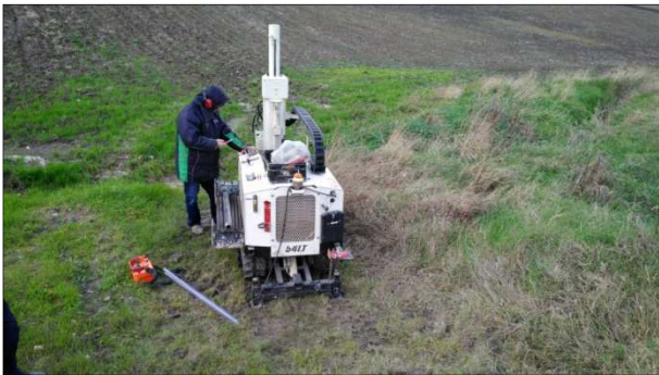
Postazione Sondaggio S5arx
