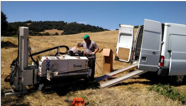
Postazione Sondaggio S2ax
