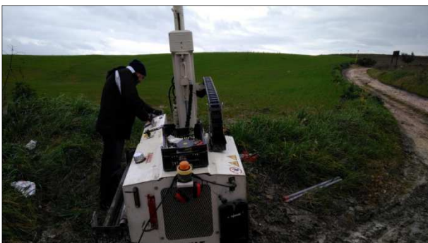
Postazione Sondaggio S8ax
