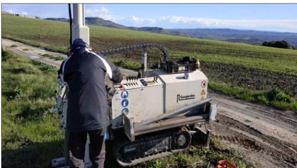
Postazione Sondaggio S4ax
