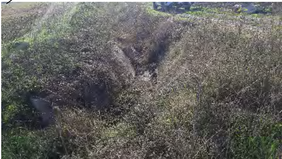
Cunetta esistente (C1)
