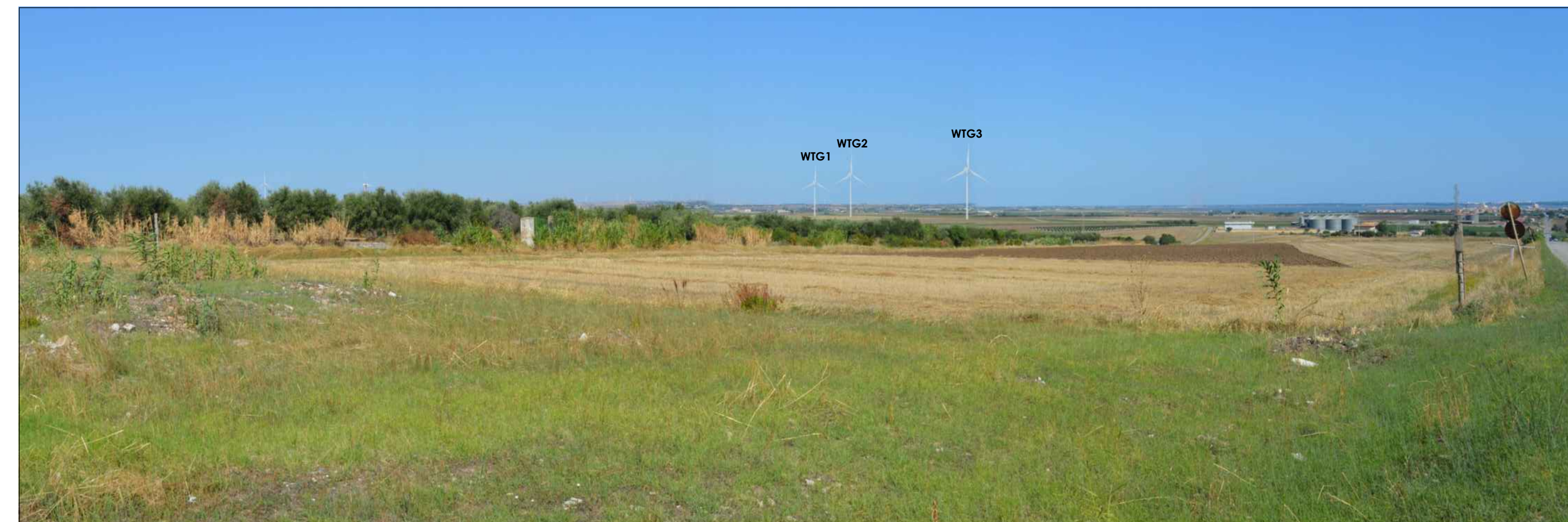
FOTOINSERIMENTO 2 : IMPIANTI ESISTENTI, AUTORIZZATI E PROGETTO IVPC Power 6 Srl
