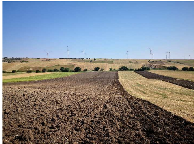
34) foto ovest-est lungo il cavidotto il collegamento alla 'pala 8'.
