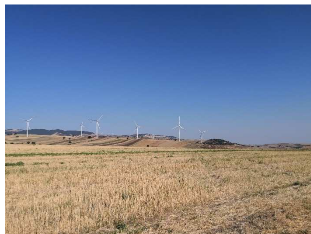
29) foto nord-sud dell'area 'pala 6'.
