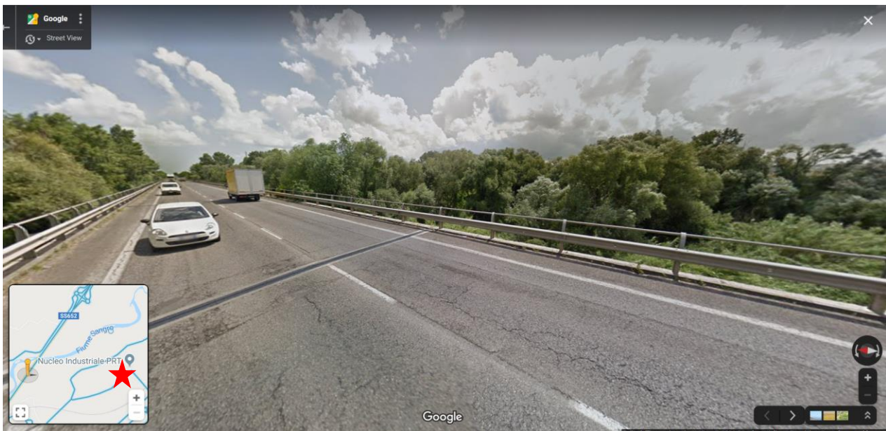
Figura 22- Visuale dalla SS652 Fondovalle Sangro, nel punto in cui la strada è sulla stessa sponda del fiume Sangro rispetto alla centrale. La vegetazione fluviale ostacola la visuale dell'area industriale.
