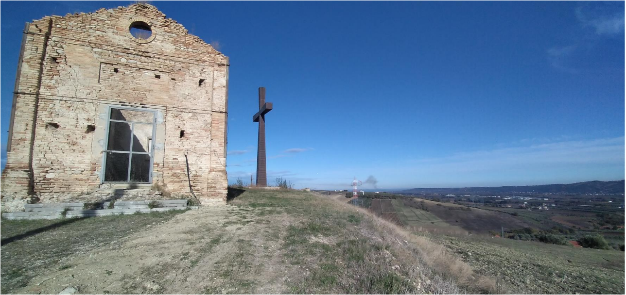
Figura 25- Croce in località Sant'Onofrio, frazione di Lanciano. Si notano sullo sfondo i tralicci dell'elettrodotto Villanova-Gissi realizzato nel 2016/2017
