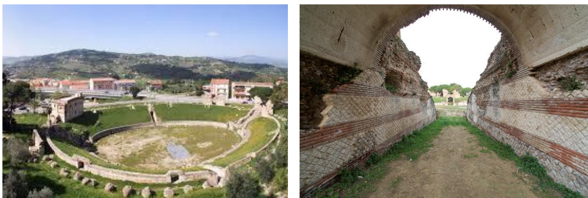
Figura 4.5.5 – Vista dell'Anfiteatro e di uno degli ingressi
