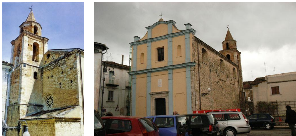
Figura 4.5.2 – Facciata ad ovest e facciata principale della chiesa
