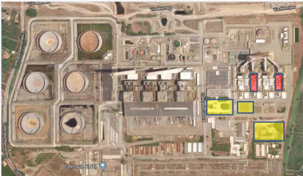
Figura 7.2.1- Ortofoto della centrale di Rossano con indicazione dei gruppi da sostituire (in rosso) e le aree di cantiere (in giallo)
