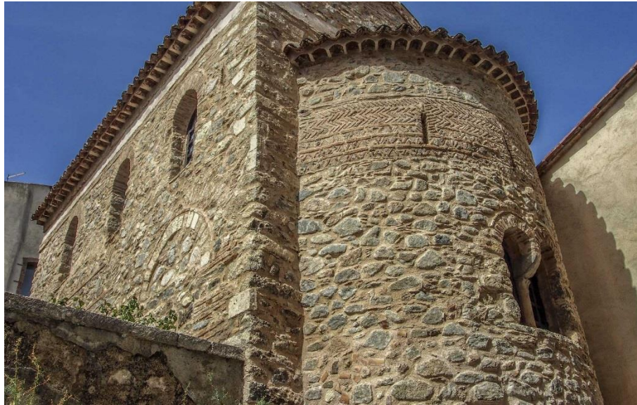
Figura 4.5.3 – Chiesa della Panaghia, abside - esterno
