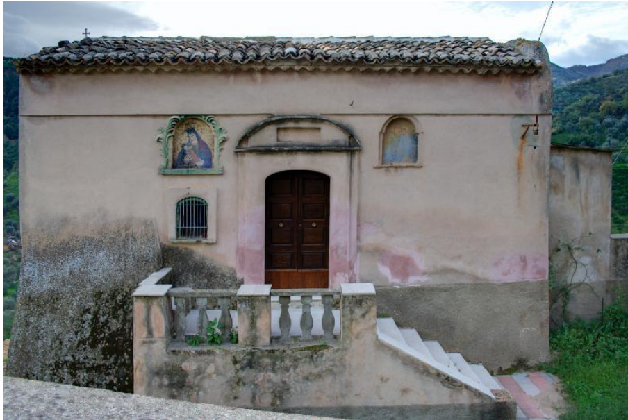
Figura 4.5.2 - Chiesa di Santa Maria del Pilerio
