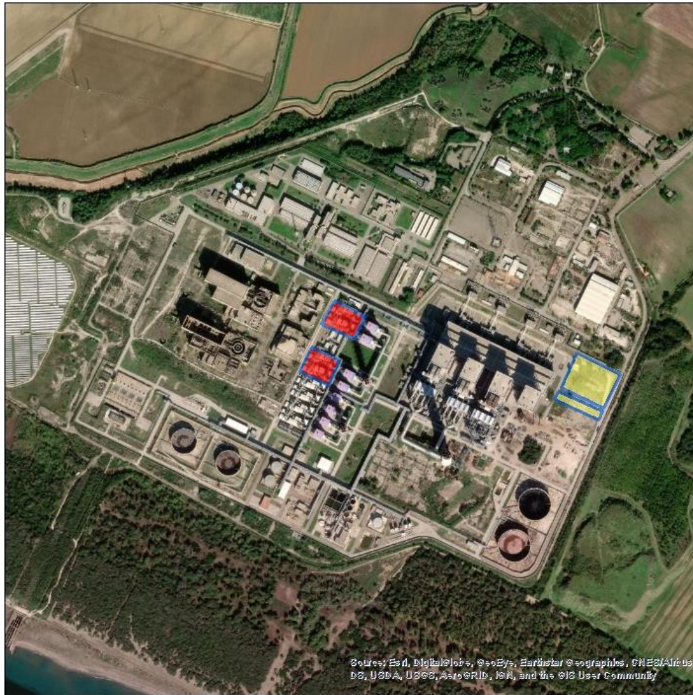
Figura 2.1 – Ortofoto della centrale con indicazione dei gruppi da sostituire (in rosso)
