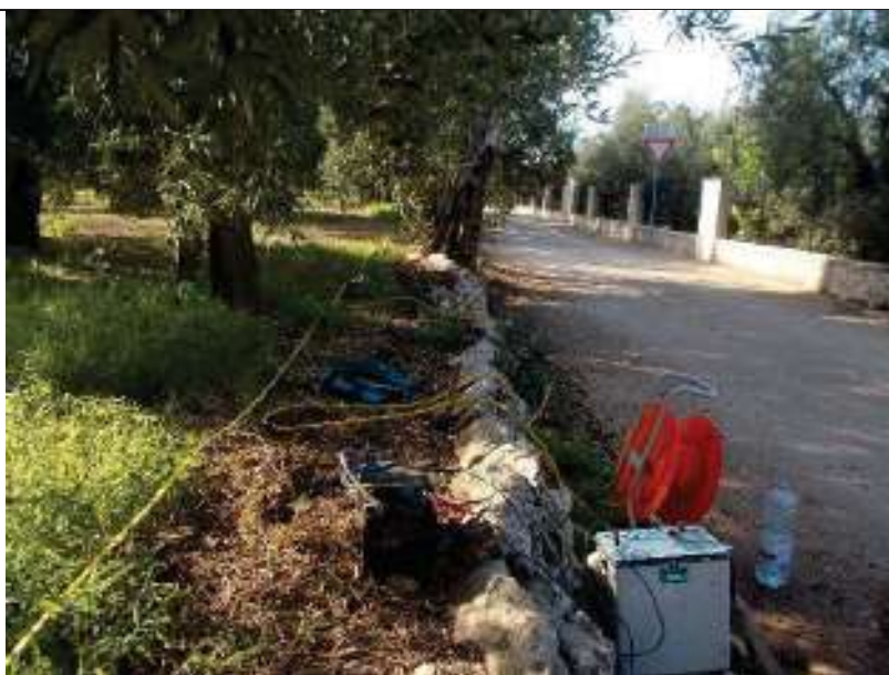
ERT.18B, con p.to di vista dell'elettrodo E24 e particolare della strumentazione
