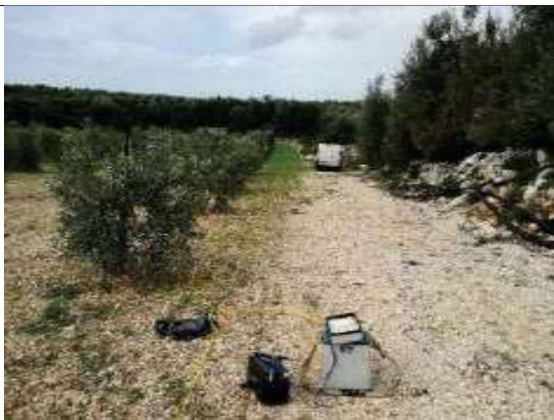
ERT.19, con p.to di vista dell'elettrodo E24 e particolare della strumentazione
