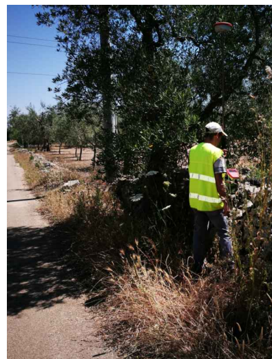
Foto 73 - Muro a secco (3048)
