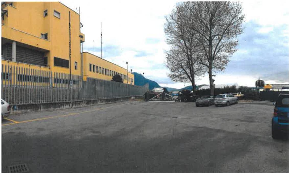
Figura 8. Viste dell'accesso NE all'area cantieristica
