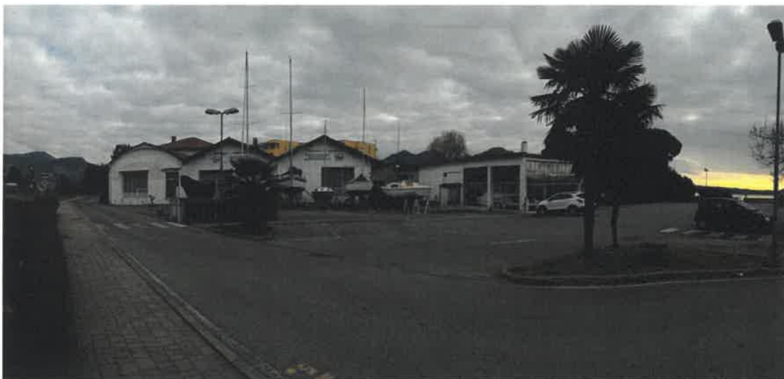
Figura 11. Vista dei capannoni di proprietà
