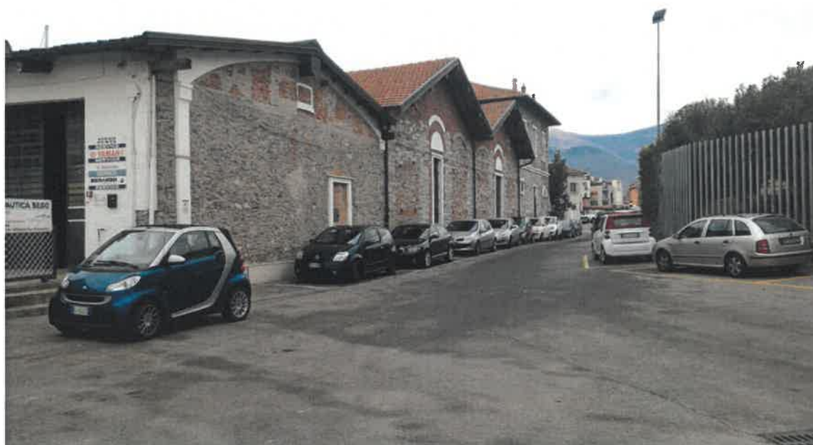
Figura 10. Vista dei capannoni di proprietà
