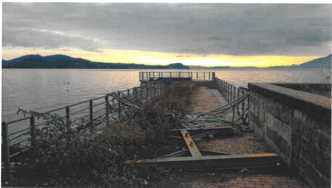
Figura 16. Vista del molo in muratura
