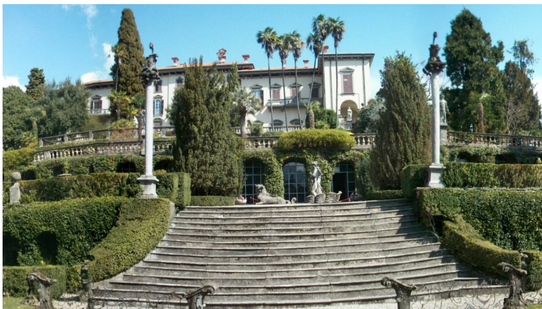
Figura 31: Vista di Villa San Remigio, localizzata in vicinanza del sito di progetto
