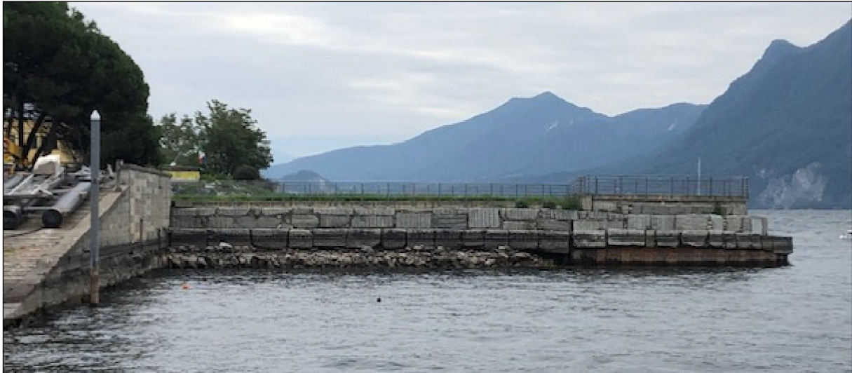
Figura 87: Vista laterale del molo esistente (da sud-ovest)
