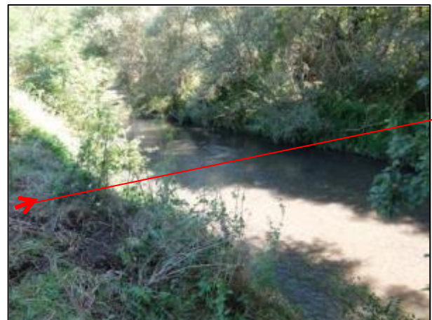
Foto 2.1.3 C – Attraversamento del F.so Leia
