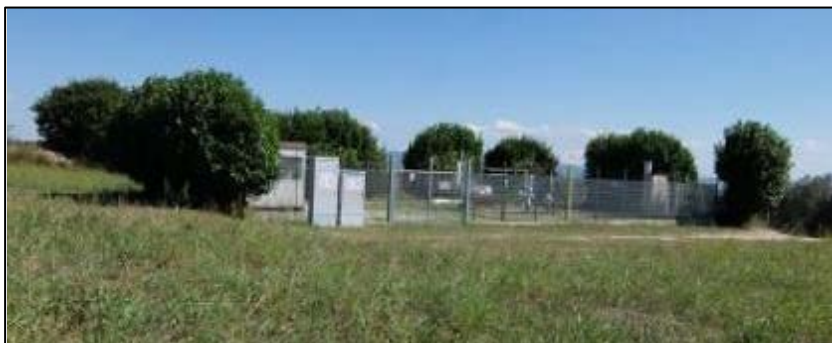
Foto 2.1.1 B – Impianto di partenza lungo il metanodotto All. Cellerio-Montalto di Castro
