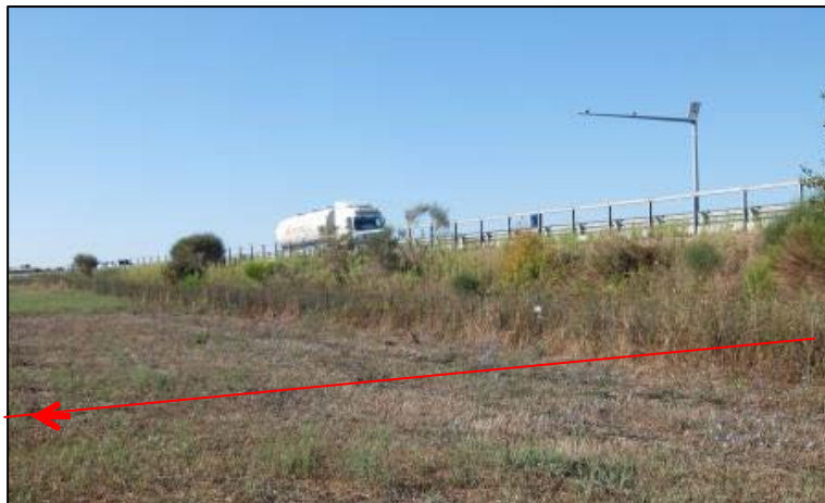
Foto 2.1.4 B – Punto di uscita dell'attraversamento della S.S. n° 675
