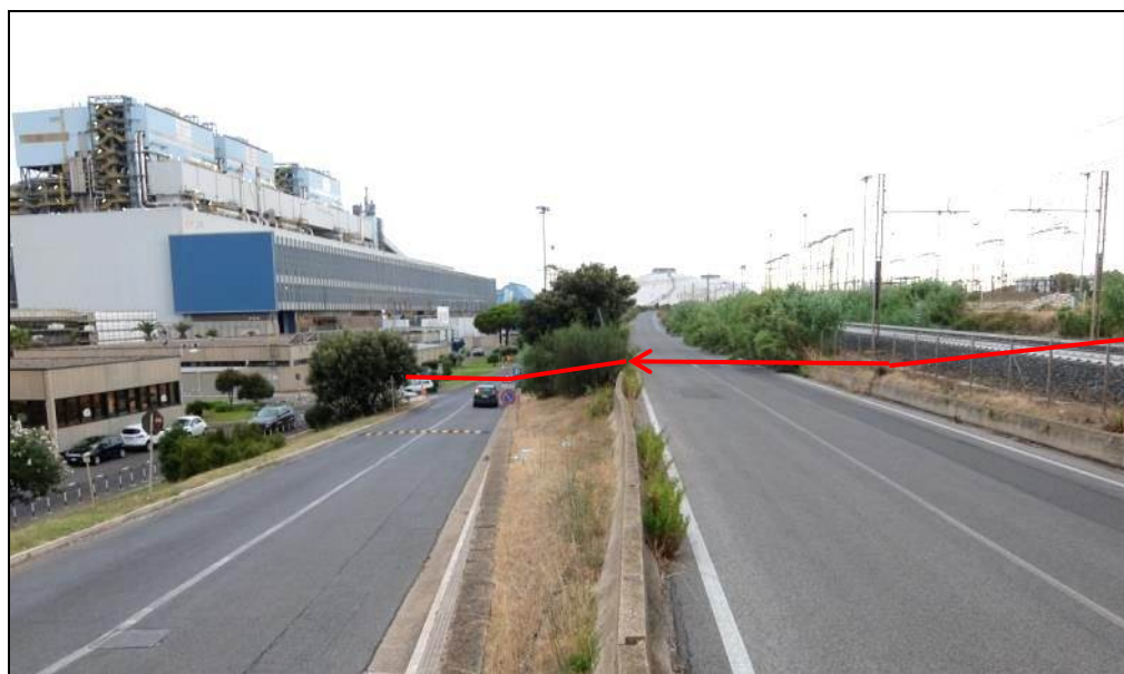
Foto 2.3 A – Discesa del tracciato lungo la scarpata, con attraversamento della linea ferroviaria, della strada della Torre Valdaliga e della strada Enel (linea rossa Pot. Allacciamento C.le Enel di Torrevaldaliga Nord (Roma) DN 400 (16") – DP 75 bar in progetto)
