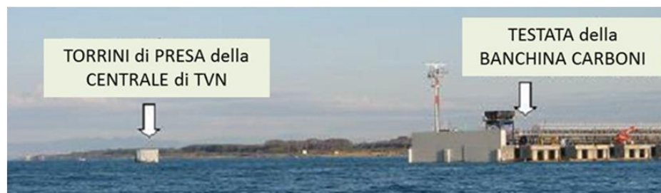
Figura 15 Particolari dell'opera di presa della centrale di TVN
