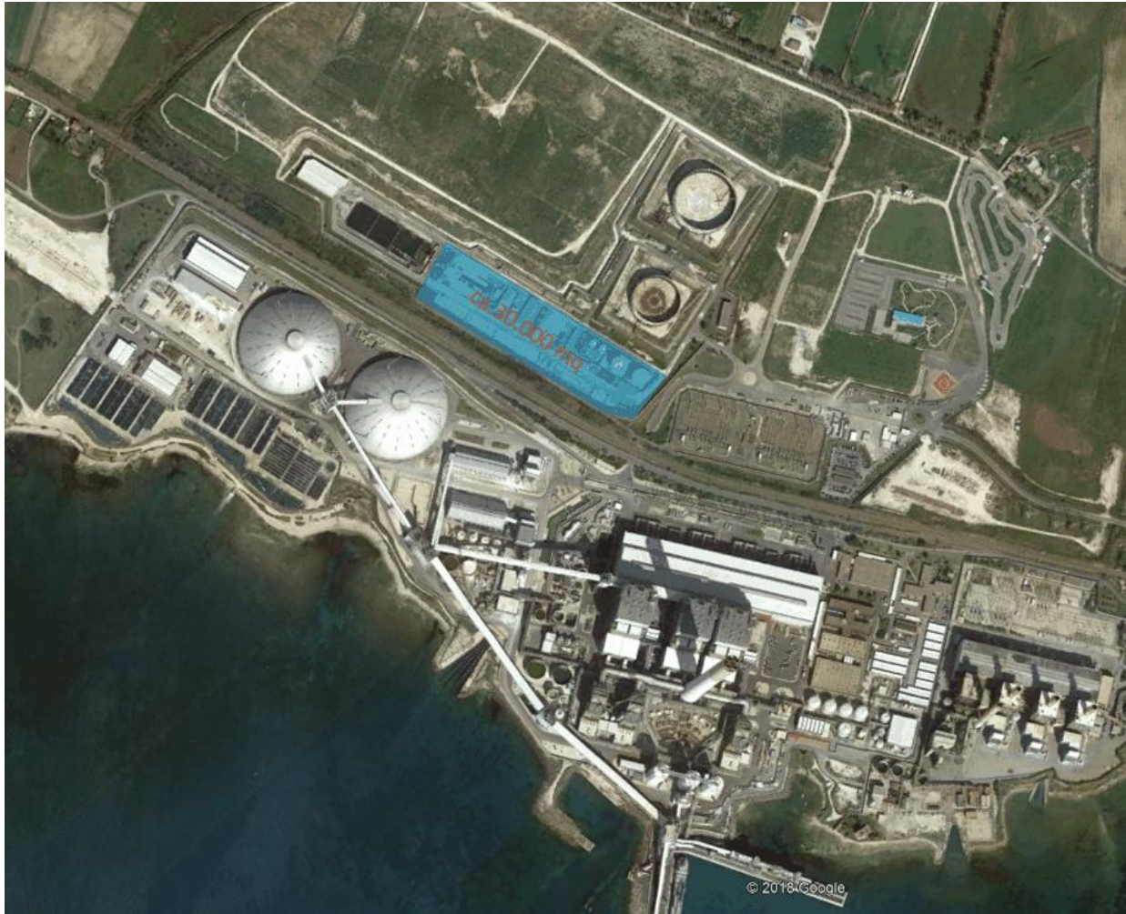
Figura 11 – C.le di Torrevaldaliga - Localizzazione dell'area di cantiere delle fasi 1 e 2
