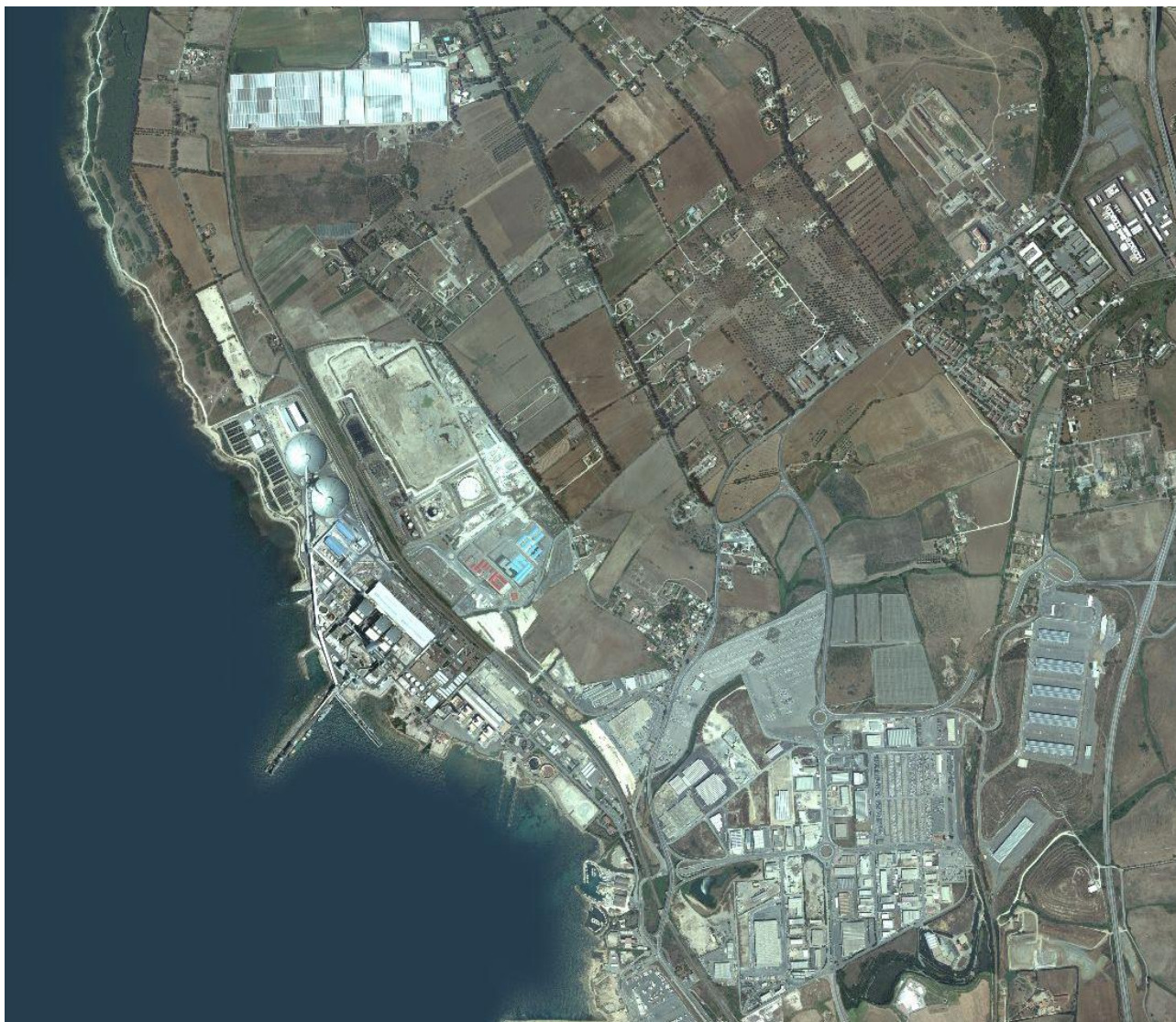
Figura 21 - L'area di Torrevaldaliga nel 2012
