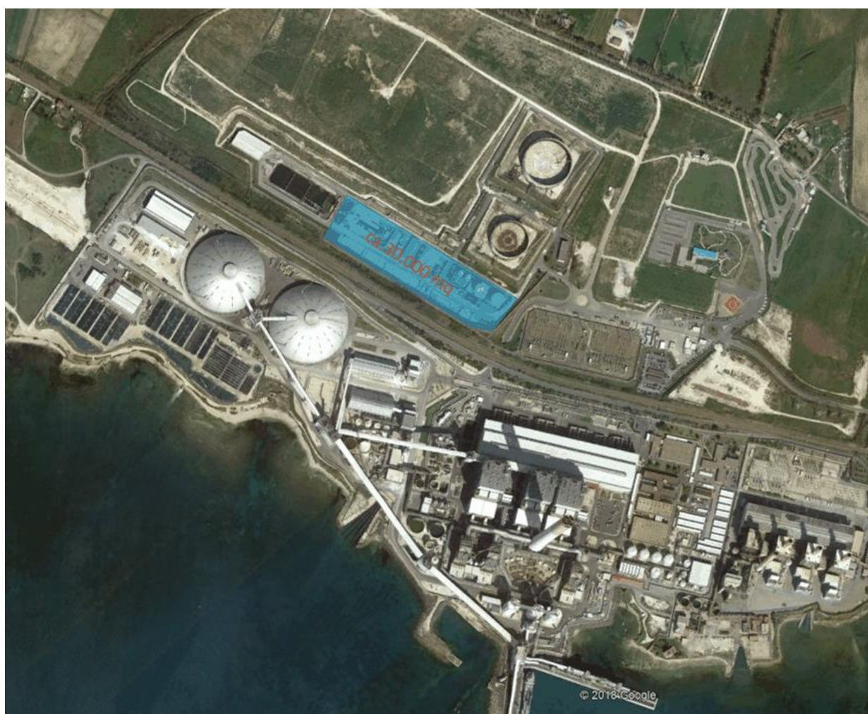
Figura 2.3-2 – Localizzazione dell'area di cantiere delle fasi 1 e 2
