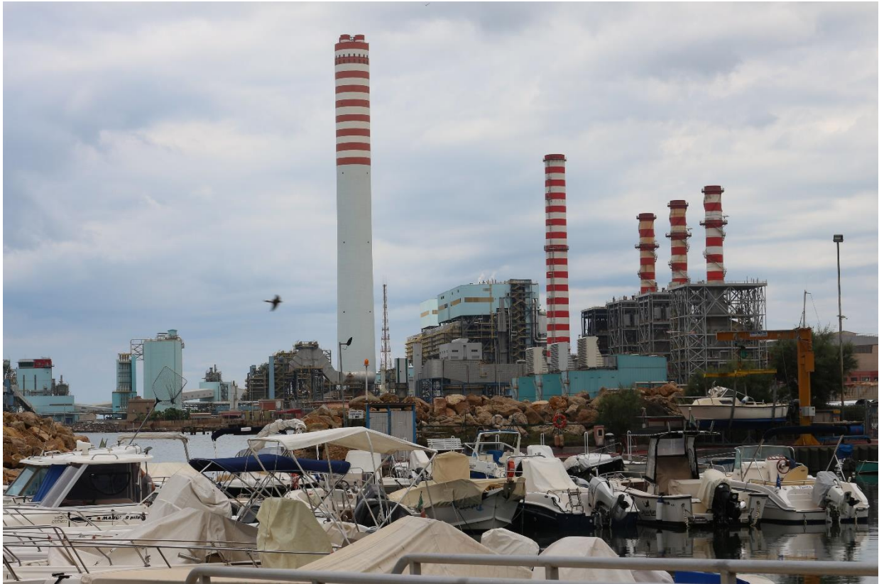
Figura 5.5-11 – Punto di vista 6 – Stato di fatto
