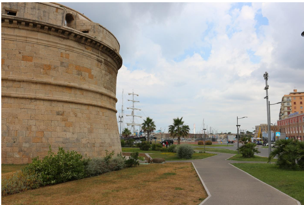
Figura 5.5-13 – Punto di vista 7 – Stato di fatto
