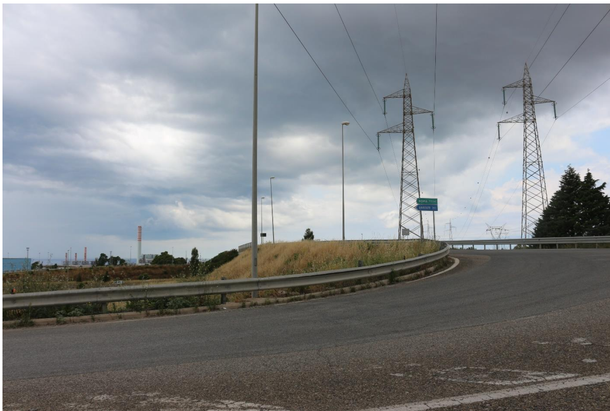
Figura 5.5-5 – Punto di vista 3 – Stato di fatto
