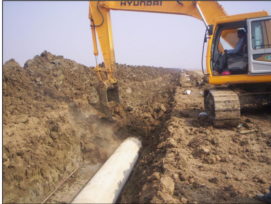
Fig. 5/H: Rinterro della condotta
