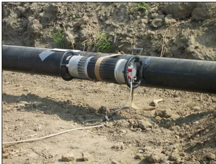
Fig. 5/E: Controlli non distruttivi delle saldature
