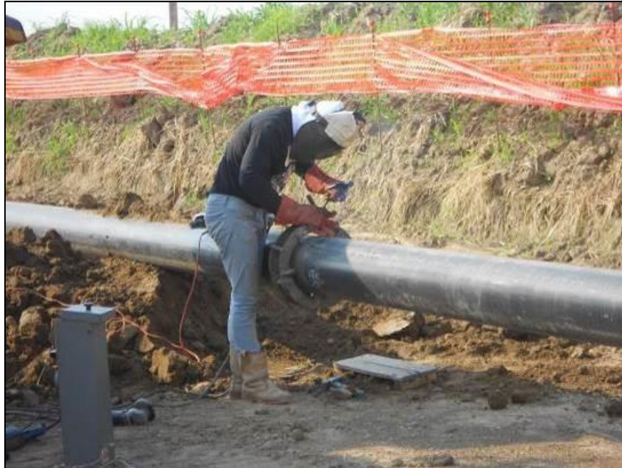
Fig. 5/D: Saldatura della tubazione
