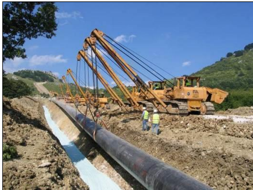
Figura 5/G – Posa della condotta
