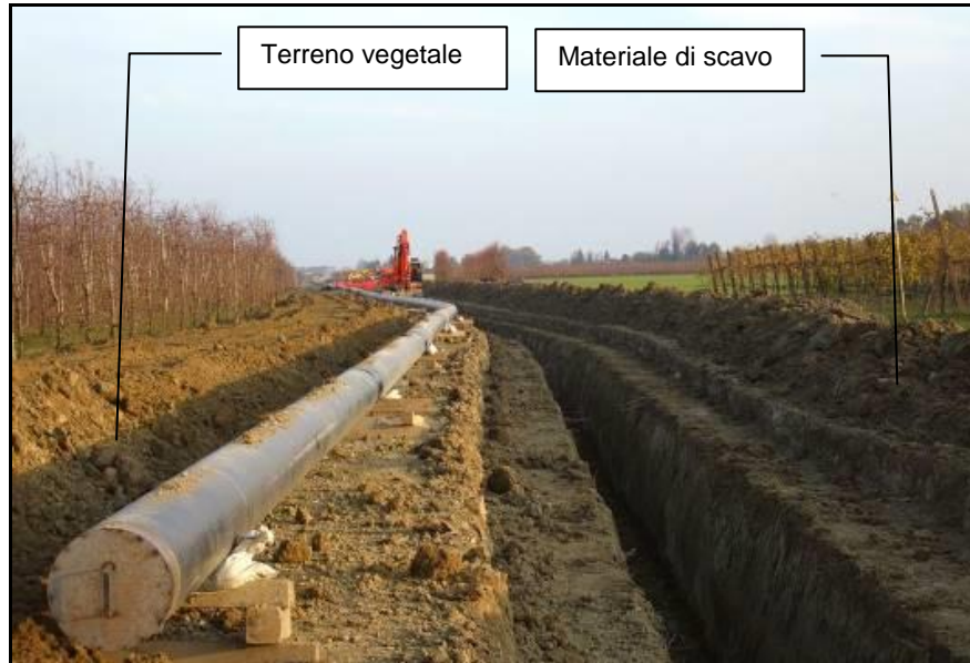
Fig. 5/F: Scavo della trincea
