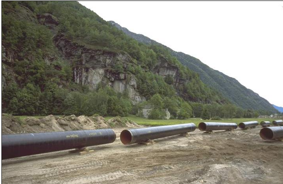
Fig. 5/C: Sfilamento tubi
