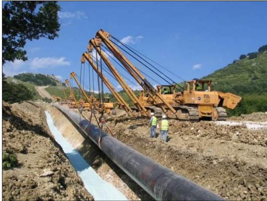
Fig. 5/G: Rinterro della condotta
