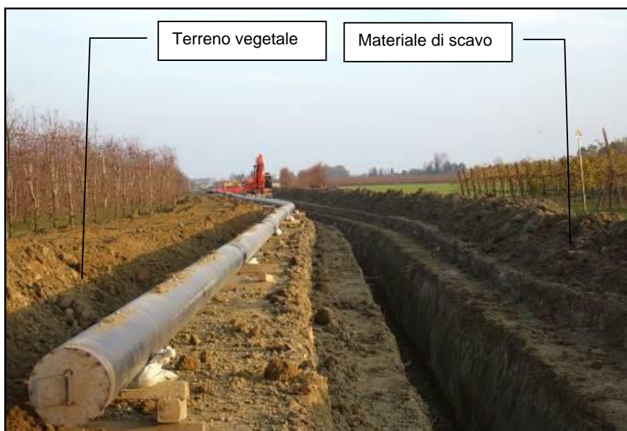
Fig. 5/F: Scavo della trincea
