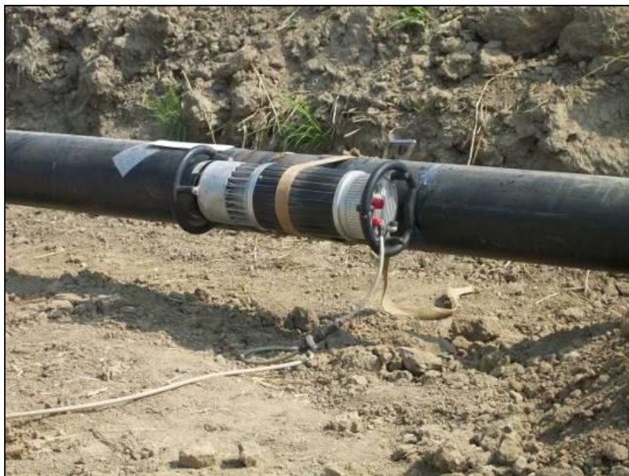
Fig. 5/E: Controlli non distruttivi delle saldature
