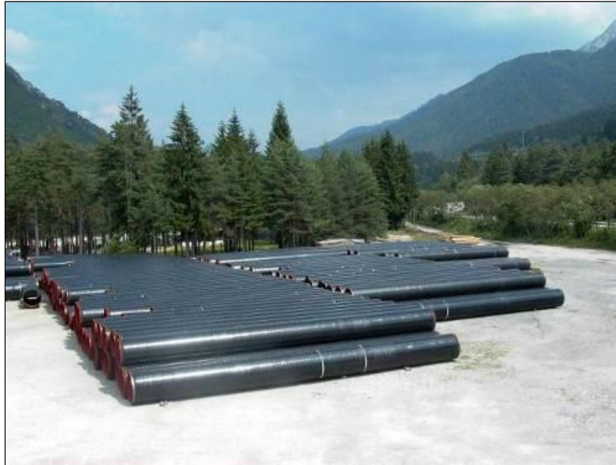
Fig. 5/A: Piazzola di accatastamento tubazioni
