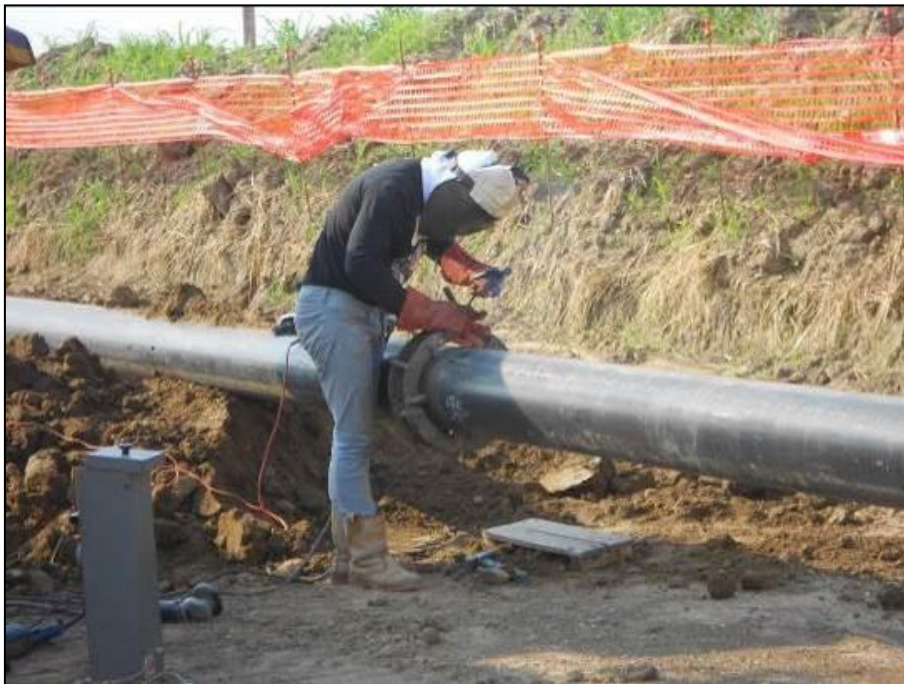
Fig. 5/D: Saldatura delle tubazioni
