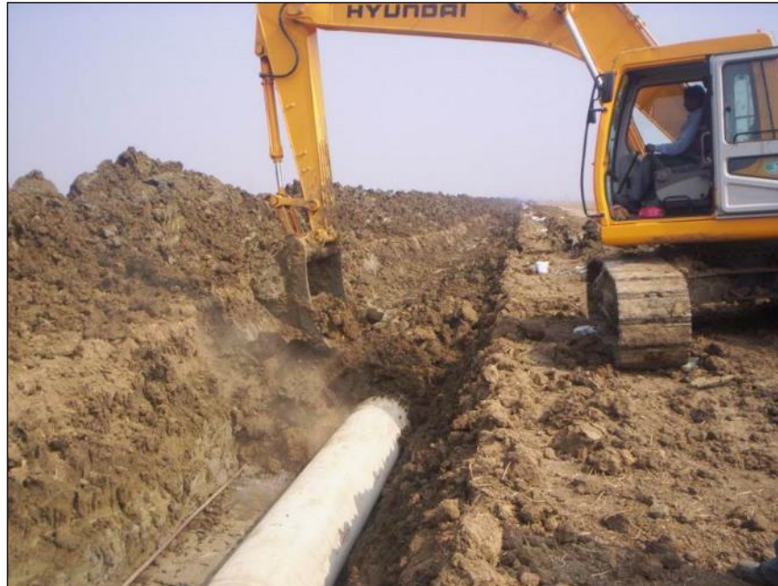
Fig. 5/H: Rinterro della condotta
