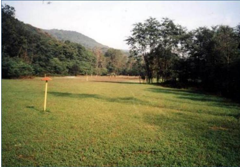
Fig. 5/M – Pista di lavoro ad opera ultimata su un gasdotto in esercizio
