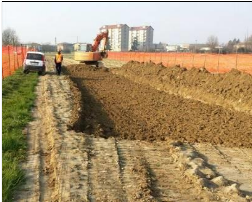
Fig. 5/B: Apertura della pista di lavoro
