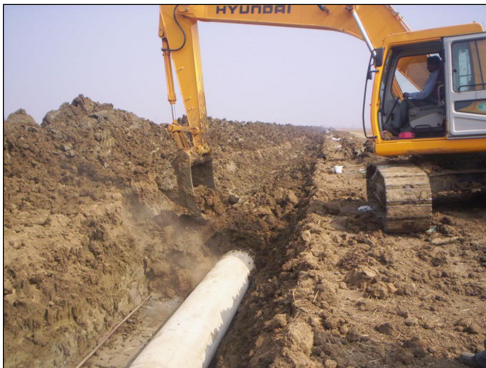
Figura 5.1.10 - Rinterro della condotta
