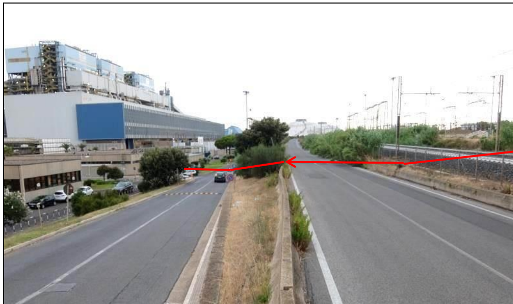
Foto 2.3-C – Discesa del tracciato lungo la scarpata, con attraversamento della linea ferroviaria, della strada della Torre Valdaliga e della strada Enel (linea rossa Pot. Allacciamento C.le Enel di Torrevaldaliga Nord (Roma) DN 400 (16") – DP 75 bar in progetto)
