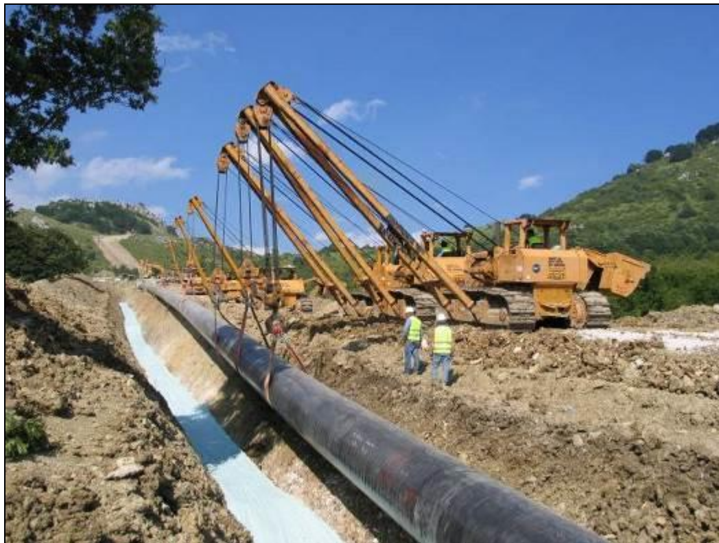
Figura 5.1.9 – Posa della condotta
