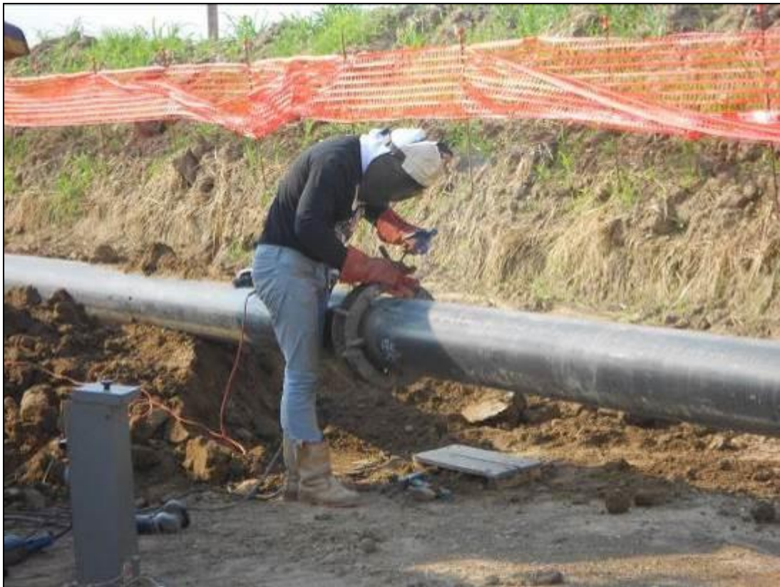
Fig. 5.1.5: Saldatura della tubazione
