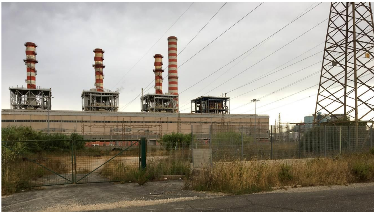
Figura 2.6.1/C – Vista percepibile dalla ferrovia in direzione della Torre da cui prende il nome la località di intervento, completamente nascosta dalle strutture della Centrale
