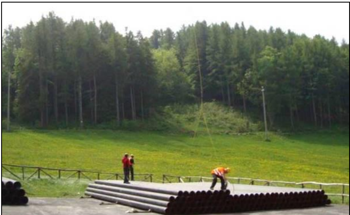
Fig. 5.1.1 - Piazzola di accatastamento tubazioni
