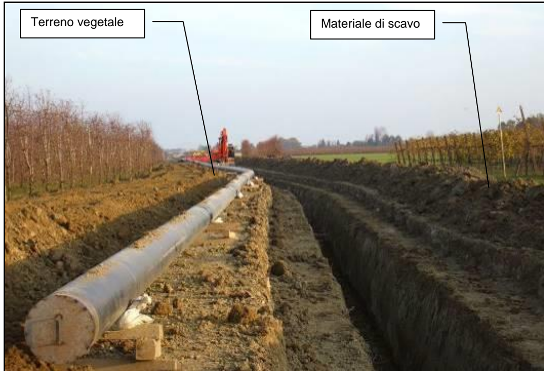
Figura 5.1.7 - Scavo della trincea
