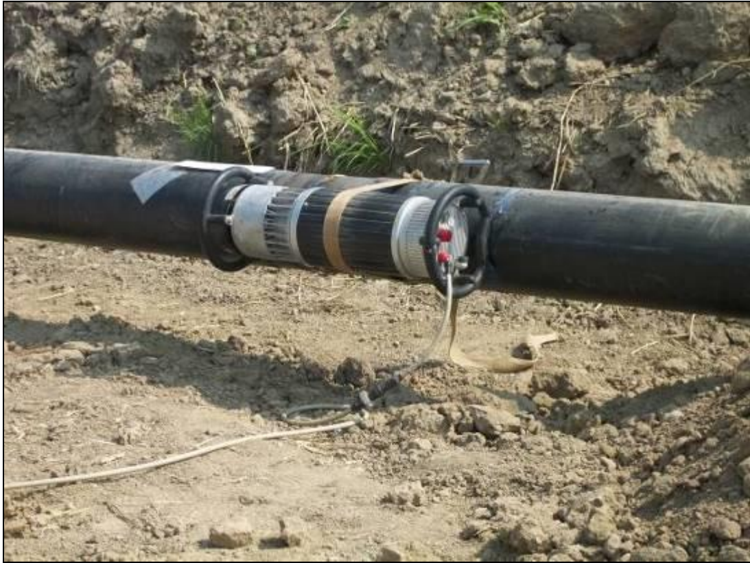
Fig. 5.1.6: Controlli non distruttivi delle saldature
