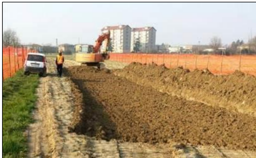
Fig. 5.1.2 - Apertura della pista di lavoro
