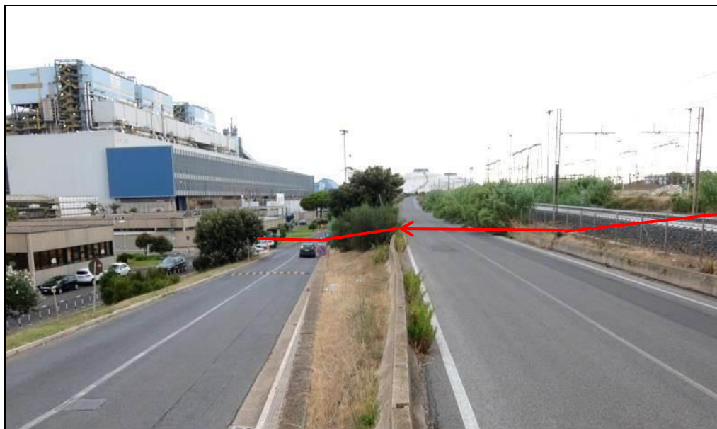
Foto 3.1.1/C – Discesa del tracciato lungo la scarpata, con attraversamento della linea ferroviaria, della strada della Torre Valdaliga e della strada Enel (linea rossa Pot. Allacciamento C.le Enel di Torrevaldaliga Nord (Roma) DN 400 (16") – DP 75 bar in progetto.
