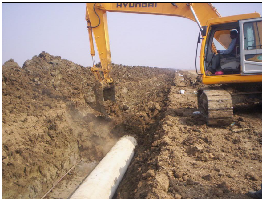
Fig. 2.3/E: Rinterro della condotta
