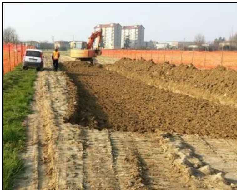
Fig. 2.3/B: Apertura della pista di lavoro
