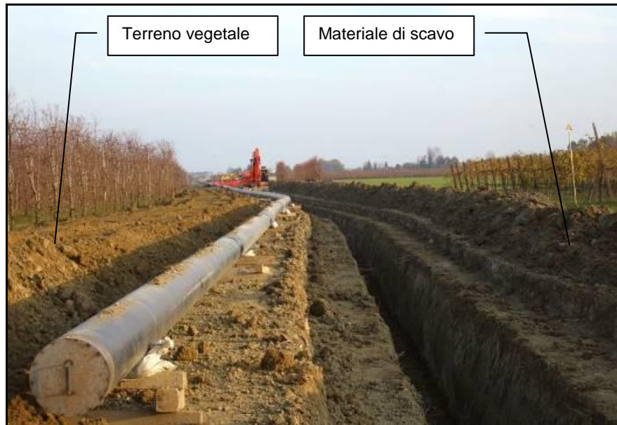
Fig. 2.3/D: Scavo della trincea
